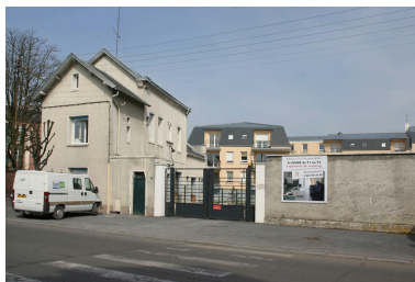
Le site, vu depuis le boulevard Vitor-Hugo. Phot. Frédéric Pillet IVR22_20050205461NUCA
