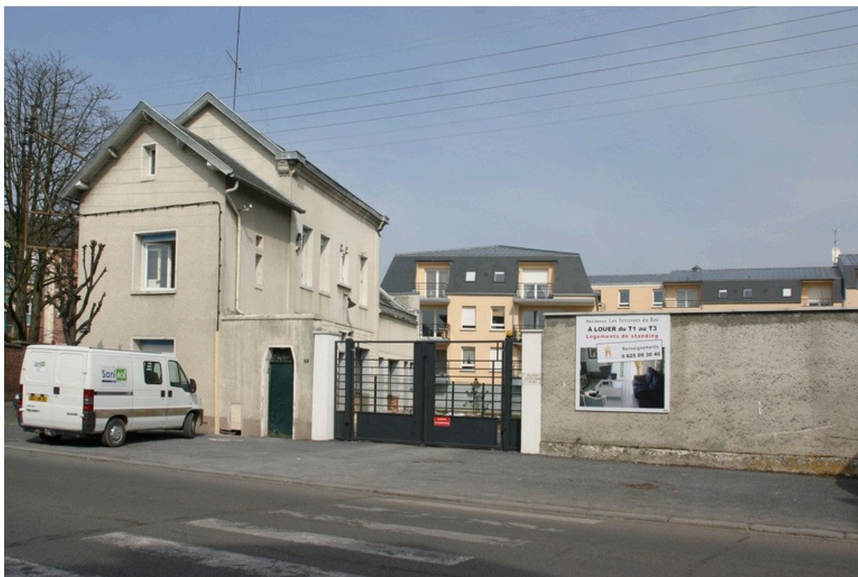
Le site, vu depuis le boulevard Vitor-Hugo.
