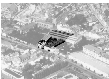
Vue aérienne du site en 1989. Phot. Pillet Frédéric, Autr. Phot'R IVR22_20050205458NUCA
