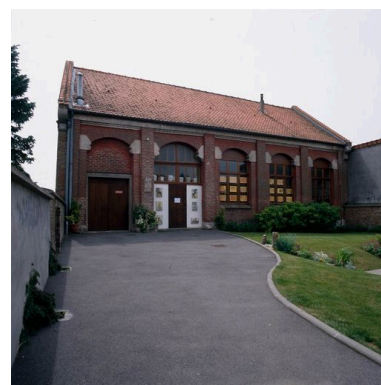
La salle de classe. Phot. Thierry Lefébure IVR22_20038000469XA
