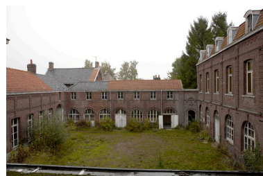
Vue générale de la cour orientale : l'aile sur rue, les communs, l'accès au jardin, l'aile méridionale. Phot. Pierre Thibaut IVR31_20095903351NUCA
