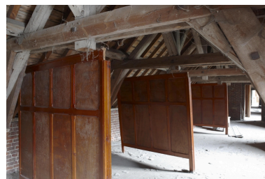
Les combles de l'aile sur rue. Phot. Pierre Thibaut IVR31_20095903346NUCA
