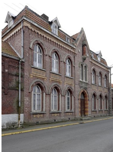
L'entrée principale. Phot. Pierre Thibaut IVR31_20095903372NUCA
