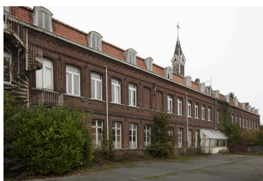
le bâtiment méridional, élévation sud, sur la cour arrière. Phot. Pierre Thibaut IVR31_20095903368NUCA
