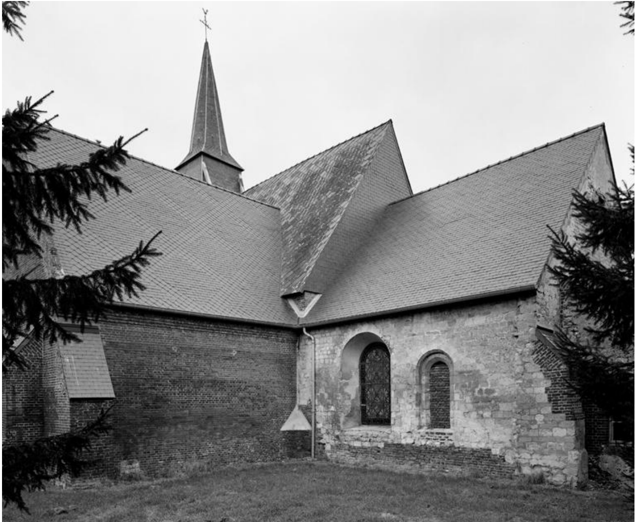
Vue du choeur et de la chapelle sud de l'église.
