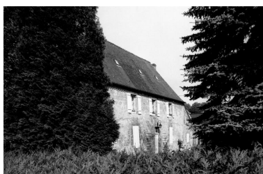
Vue partielle de l'élévation arrière du logis prioral. Phot. Thierry Lefébure IVR22_19920201198Z
