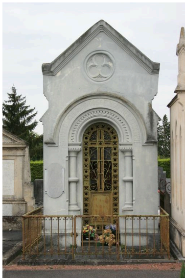
Vue de la façade antérieure. Phot. Isabelle Barbedor IVR22_20078010109NUCA
