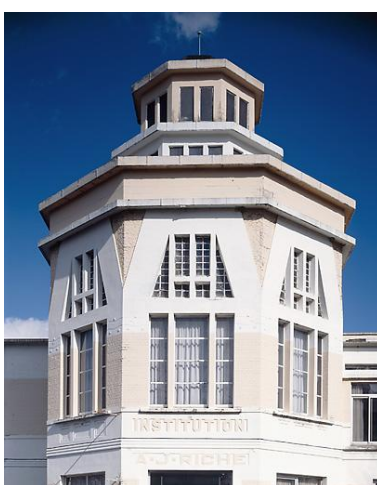
Élévation antérieure du hall d'accueil. Phot. Olivier Marlard IVR31_19955900506VA
