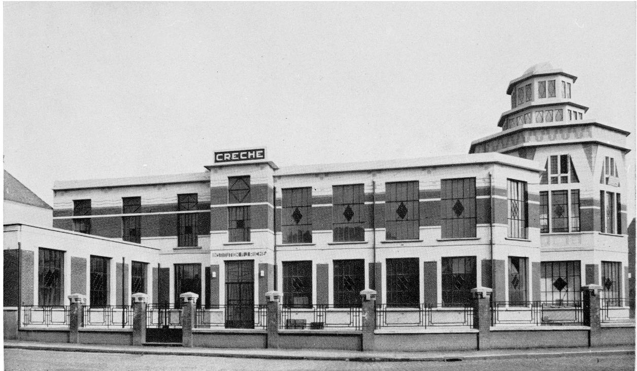
Élévation antérieure de la crèche vers 1933. Extrait du Recueil d'architecture d'Adolphe Danis, 1927-1934 (AP Dieux).
