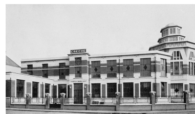
Élévation antérieure de la crèche vers 1933. Extrait du Recueil d'architecture d'Adolphe Danis, 1927-1934 (AP Dieux). Repro. Olivier Marlard IVR31_19925901778XB
