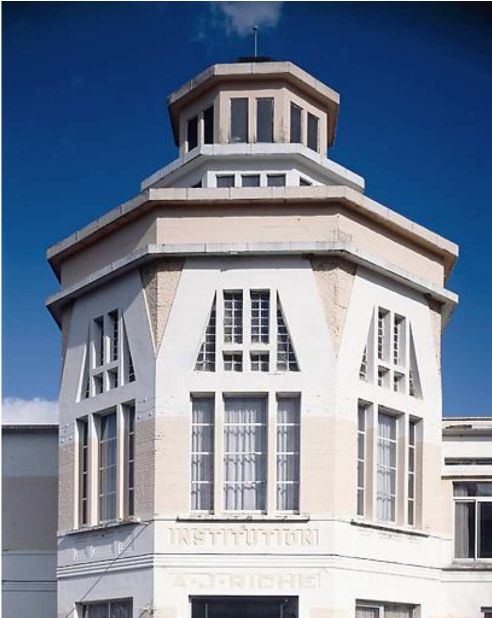
Élévation antérieure du hall d'accueil.
