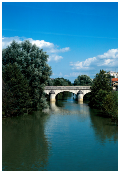
Pont sur la Marne. Phot. Thierry Lefébure IVR22_19940200817XA
