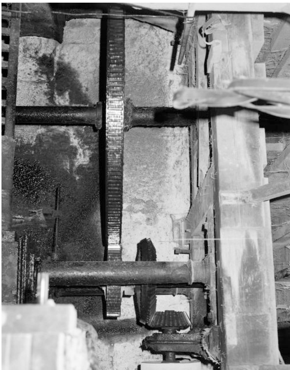
Vue intérieure du moulin, rez-de-chaussée : mécanisme de la roue principale et des engrenages.
