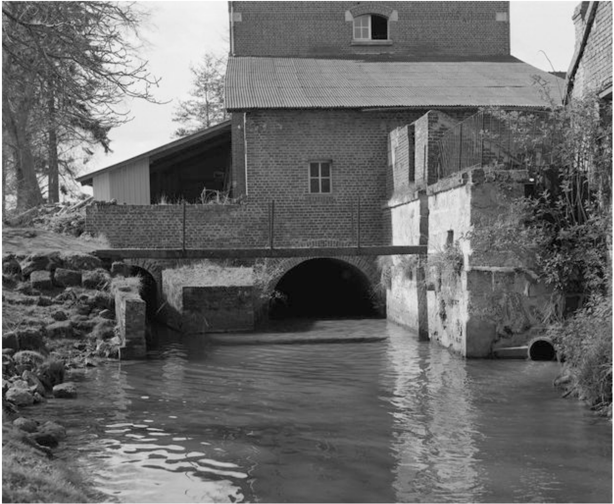
Cage du moulin. Elévation latérale.
