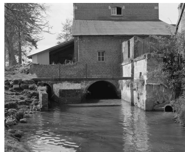
Cage du moulin. Elévation latérale. Phot. Jean-Michel Perrin IVR22_19856000629X
