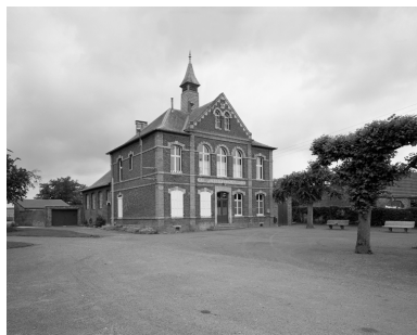
Vue de situation depuis le sud-est. Phot. Thierry Lefébure IVR22_19910201066V
