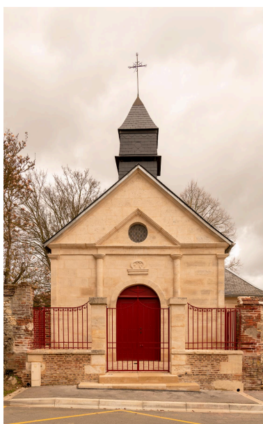
Chapelle Saint-Prix, rue de Grandivilliers. Phot. Marc Kérignard IVR32_20236000318NUCA
