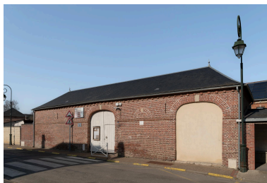
École primaire Philippe Honoré, rue de l'Église, vue prise depuis le sud. Phot. Marc Kérignard IVR32_20236000193NUCA
