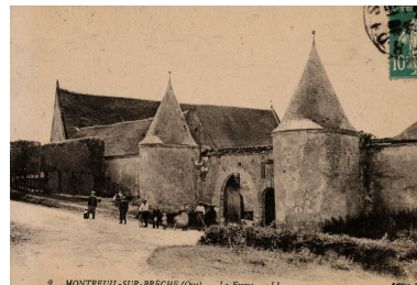
Montreuil-sur-Brèche (Oise). "La ferme", carte postale, éd. Bazin, [premier quart du XXe siècle] (coll. part.). Repro. Marc Kérignard IVR32_20226000186NUCA
