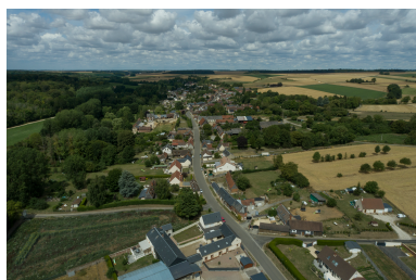
Vue aérienne depuis l'est du village. Phot. Marc Kérignard IVR32_20236000818NUCA
