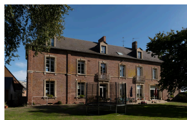
Logis, vue depuis le sud, côté jardin. Phot. Marc Kérignard IVR32_20226001086NUCA
