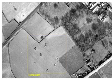
Situation de l'ensemble de casemate sur une photographie aérienne du 13 mars 1965 (IGN, Geoportail). Phot. Jean-Marc Ramette IVR32_20175900926NUCA
