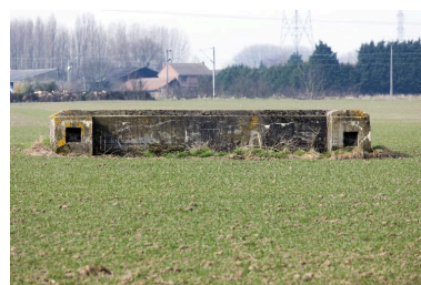
Autre ouvrage en U, vers l'ouest Phot. Jean-Marc Ramette IVR31_20135901169NUCA
