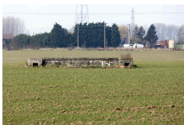
Ouvrage en U, vers l'ouest IVR31_20135901171NUCA
