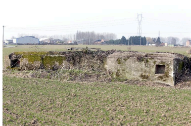
Ouvrage, en L, vers l'ouest Phot. Jean-Marc Ramette IVR31_20135901175NUCA
