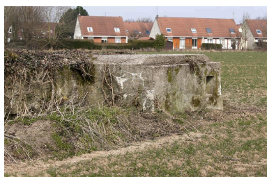
Détail de l'ouvrage en L précédent. Phot. Jean-Marc Ramette IVR31_20135901178NUCA
