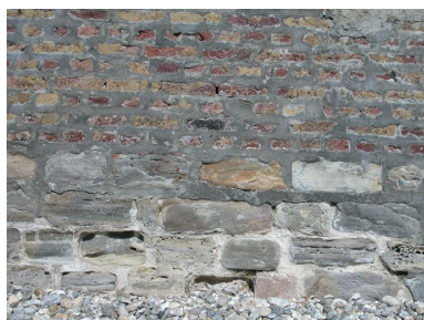
Vue de détail de la maçonnerie des rampes d'accès à la plage. Phot. Elisabeth Justome IVR22_20058003763NUCA
