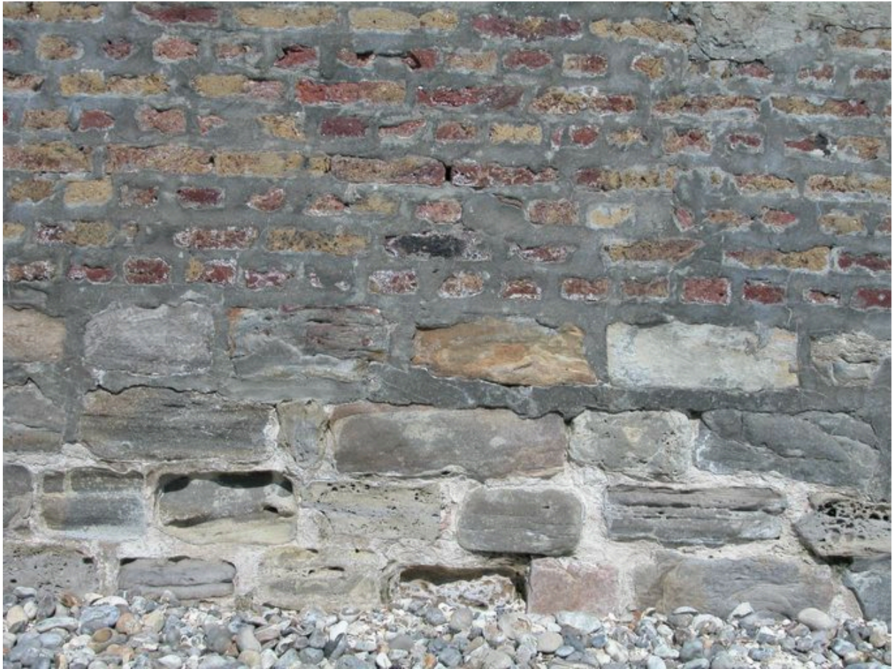
Vue de détail de la maçonnerie des rampes d'accès à la plage.
