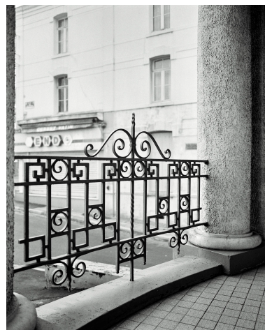
Détail de ferronnerie. Phot. Olivier Marlard IVR31_19945900338X
