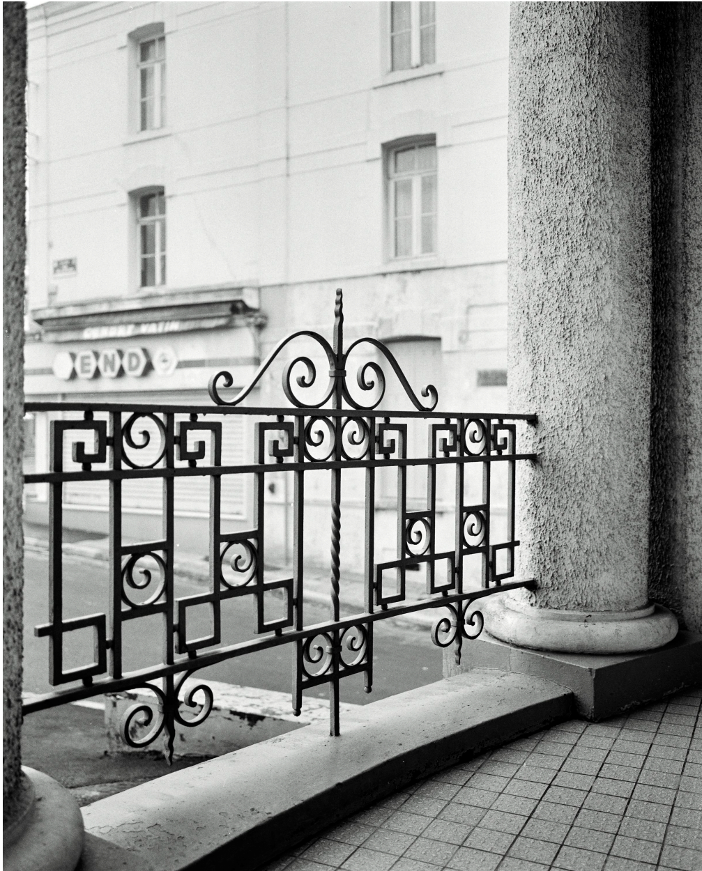
Détail de ferronnerie.
