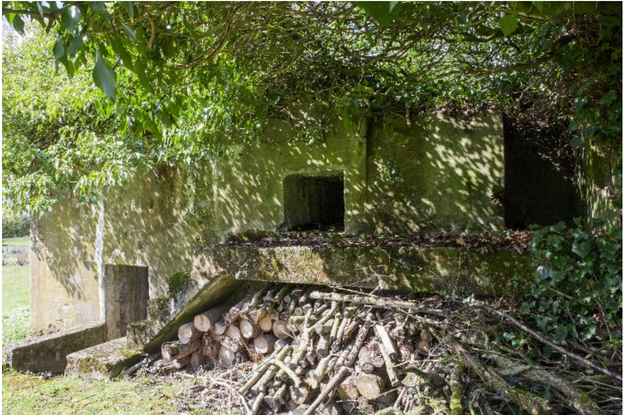
Elévation sud avec de gauche à droite, l'entrée, l'escalier menant au poste de mitrailleuse, la resserre et le poste du servant.
