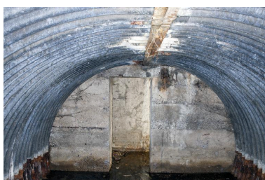
L'abri à personnel, vers le couloir Phot. Pierre Thibaut IVR32_20165900605NUCA
