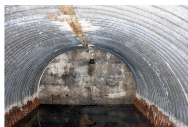
L'abri à personnel, depuis le couloir Phot. Pierre Thibaut IVR32_20165900604NUCA
