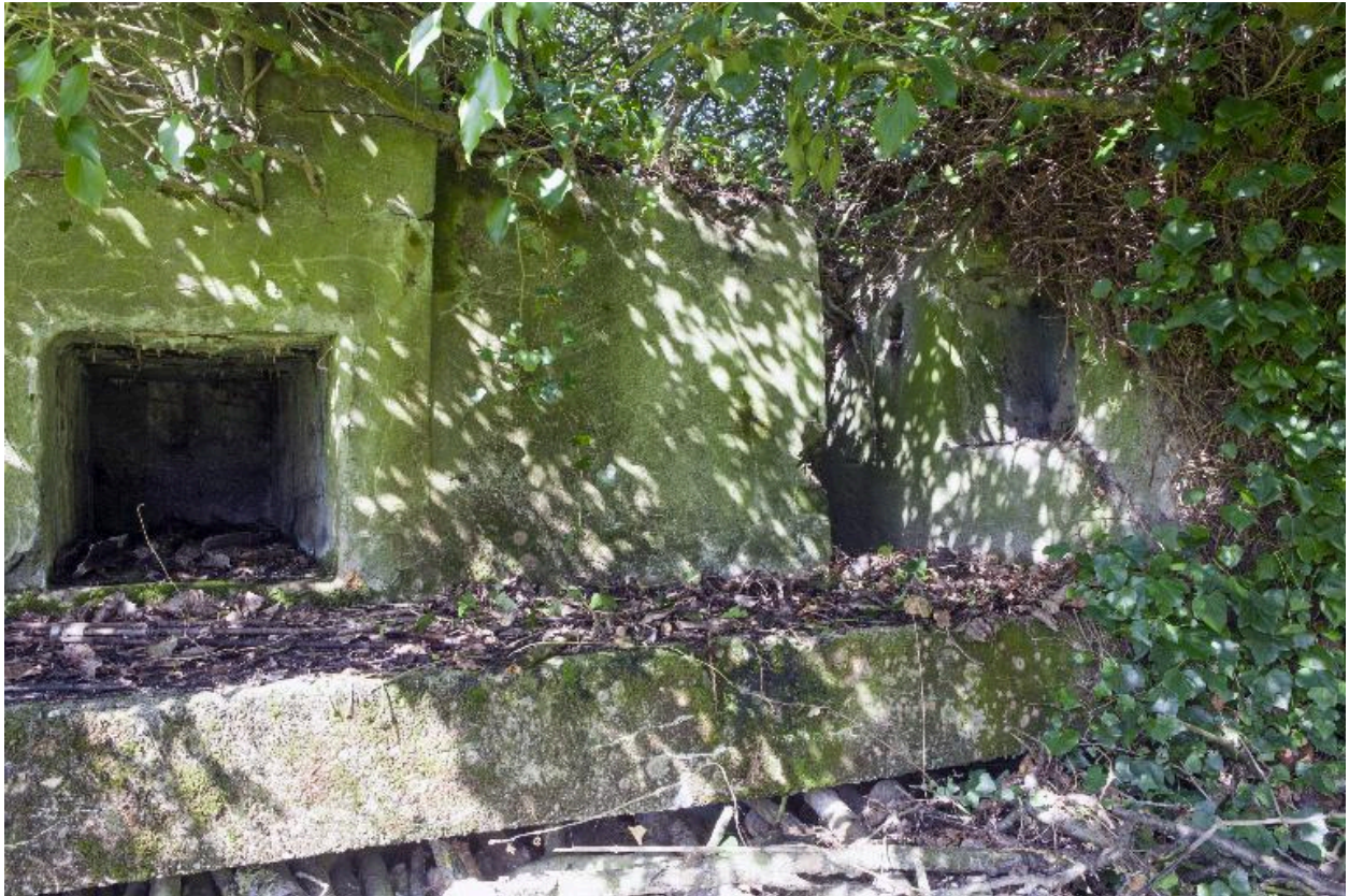
Depuis la banquette de tir : La resserre à mitrailleuse (à gauche) et le poste de mitrailleuse avec sa niche à munitions (à droite)
