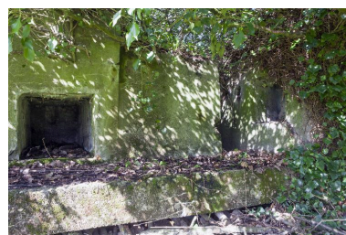
Depuis la banquette de tir : La resserre à mitrailleuse (à gauche) et le poste de mitrailleuse avec sa niche à munitions (à droite) Phot. Pierre Thibaut IVR32_20165900608NUCA
