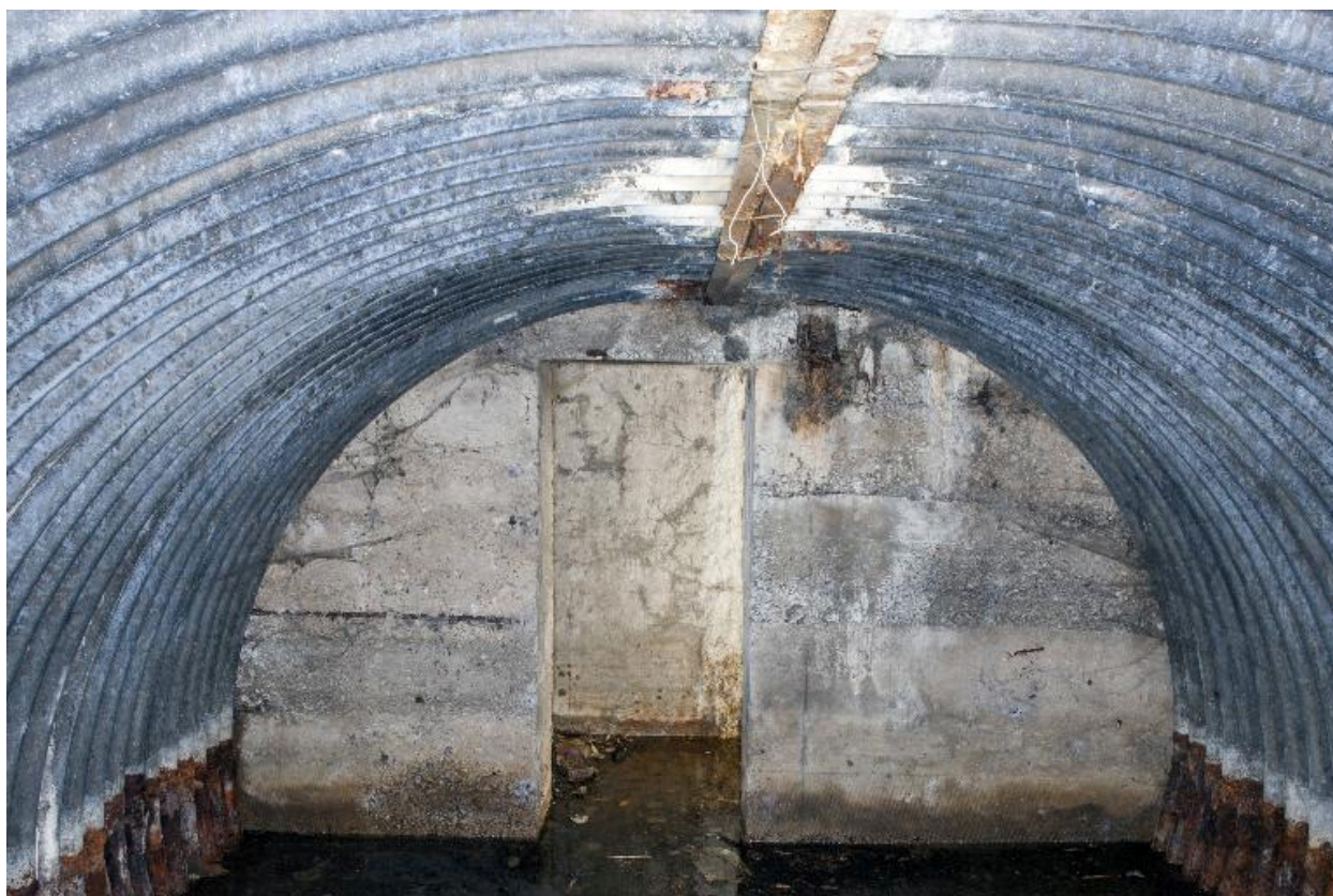
L'abri à personnel, vers le couloir
