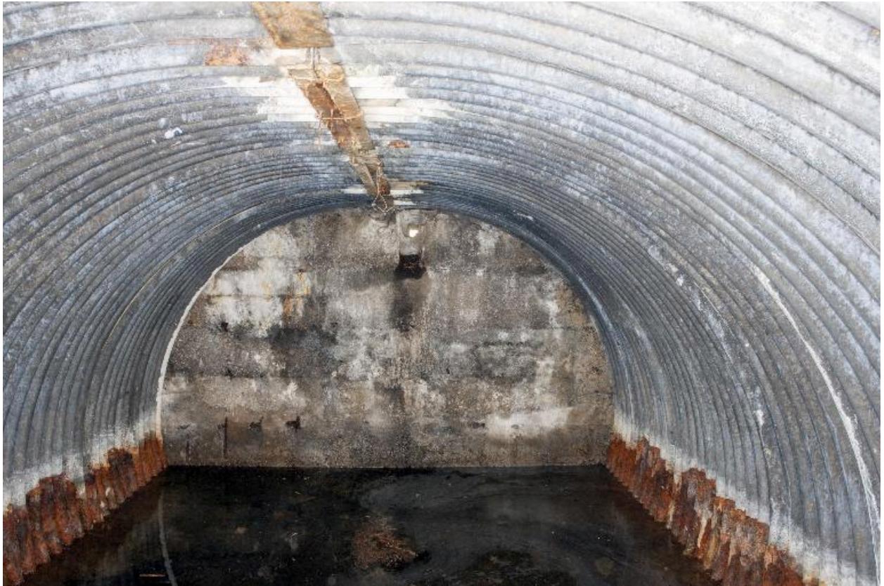
L'abri à personnel, depuis le couloir
