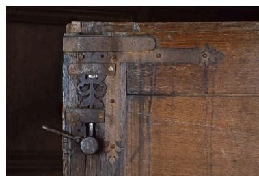
Vue du verrou d'un des battants. Phot. Irwin Leullier IVR22_20030200633ZA
