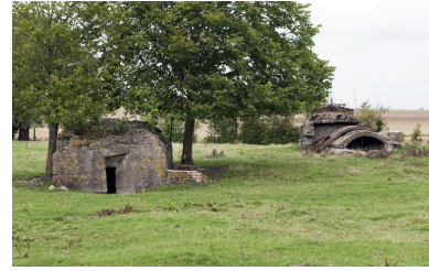
Vue générale vers le nord. (dans le fond à droite la casemate IA59004833) Phot. Pierre Thibaut IVR31_20155901463NUCA
