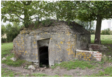
Elévation sud, entrée Phot. Pierre Thibaut IVR31_20155901464NUCA
