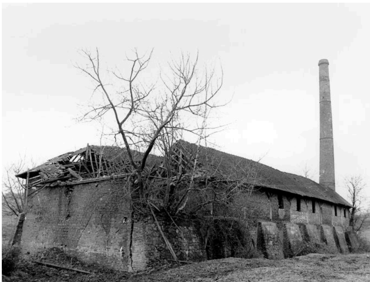
Atelier de fabrication : vue d'ensemble du four Hoffmann (Ecomusée du Beauvaisis).
