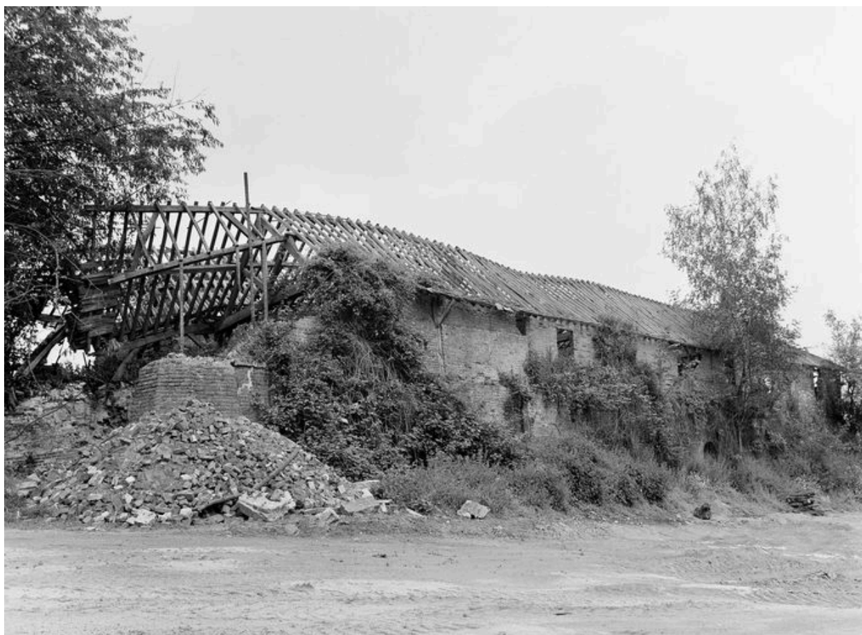
Four industriel de type Hoffmann, côté sud.
