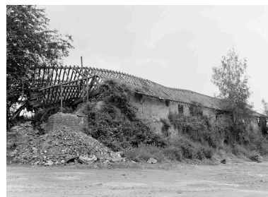
Four industriel de type Hoffmann, côté sud. Phot. Patrick Glotain IVR22_19936000618X
