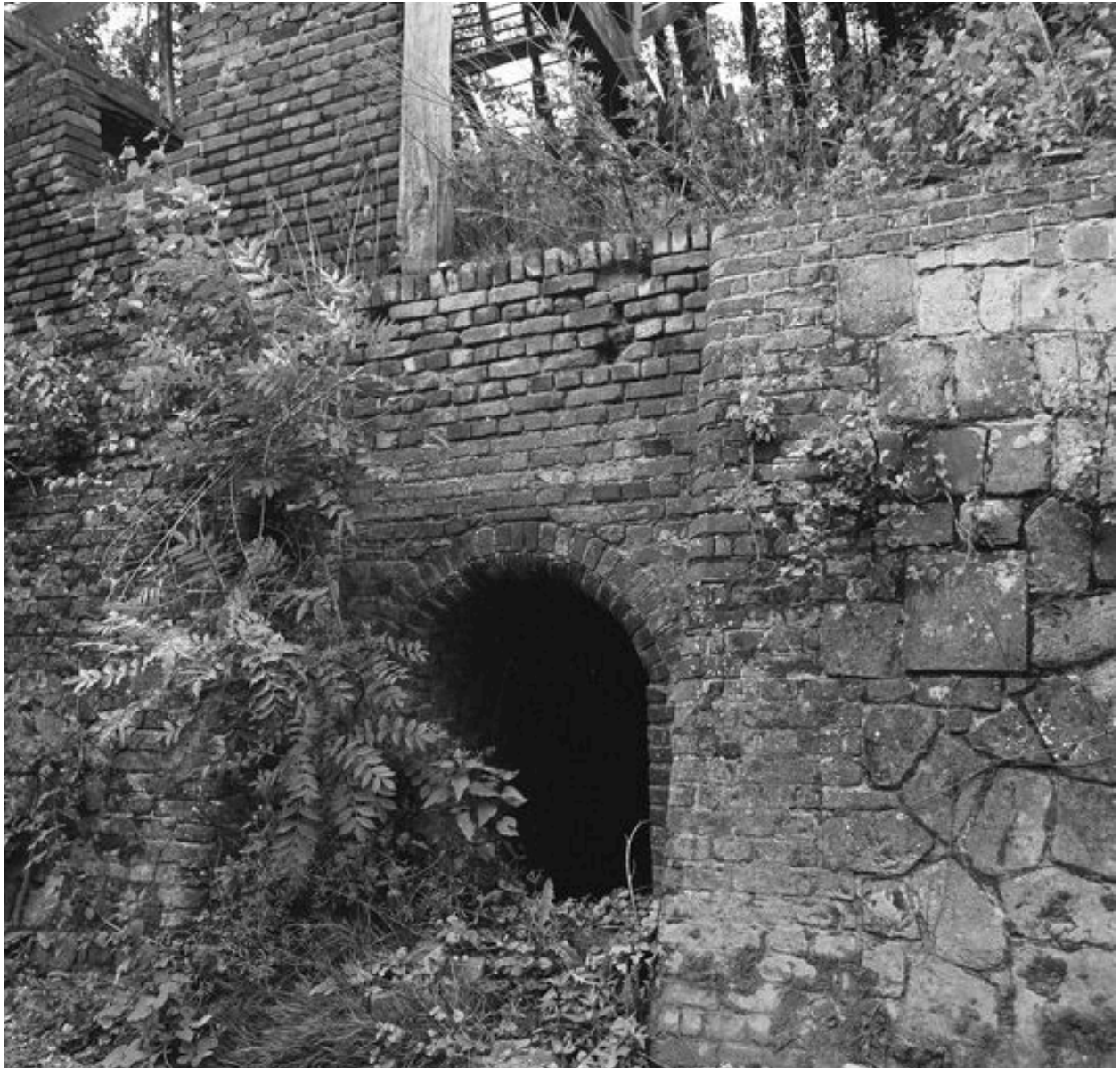
Détail d'un alandier du four Hoffmann.
