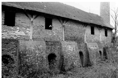
Atelier de fabrication : vue des entrées du four Hoffmann (Ecomusée du Beauvaisis). Repro. Monnehay-Vulliet Marie-Laure IVR22_20106000174NUCA
