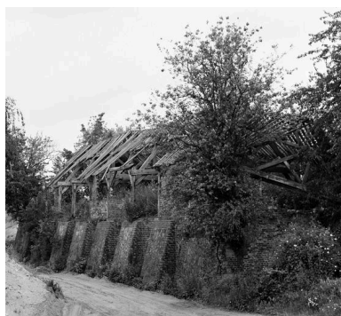
Four industriel de type Hoffmann, côté nord. Phot. Patrick Glotain IVR22_19936000614X
