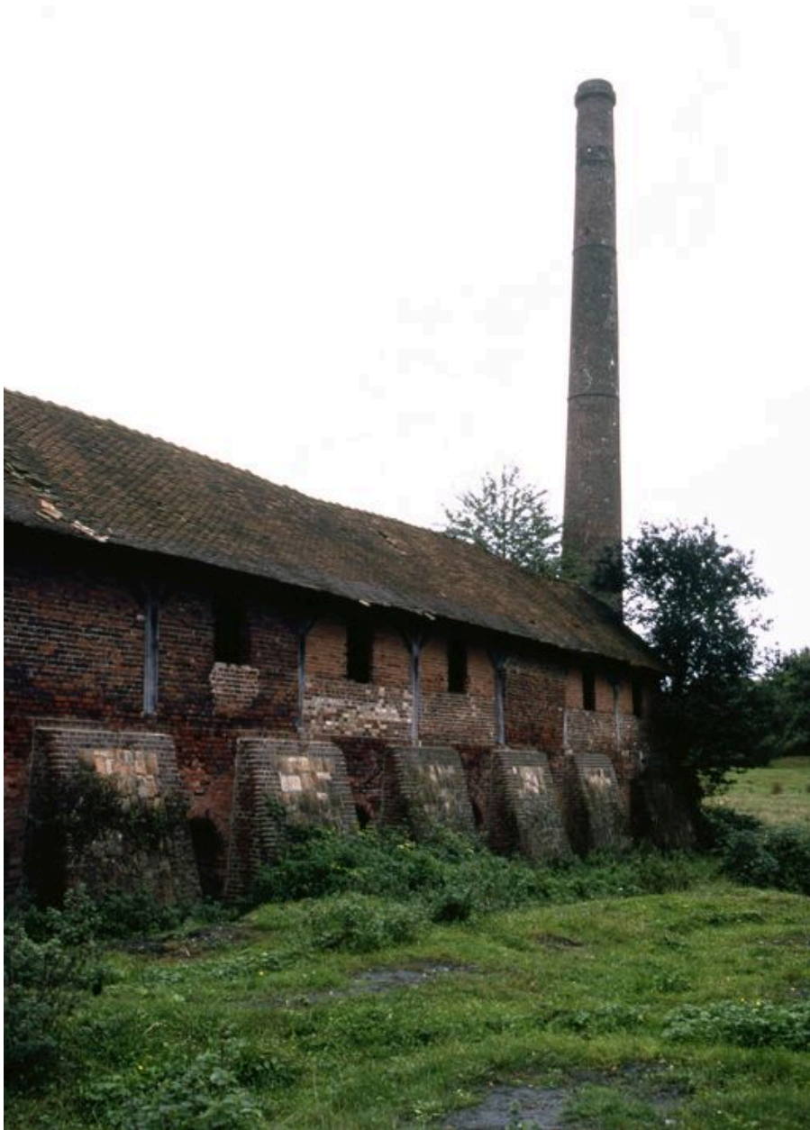
Four industriel de type Hoffmann et cheminée d'usine.
