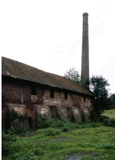
Four industriel de type Hoffmann et cheminée d'usine. Phot. Benoît Dufournier IVR22_19876000366ZA
