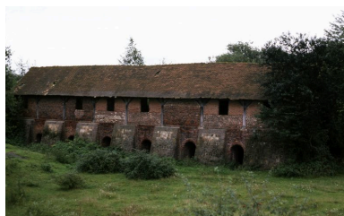
Four industriel de type Hoffmann, côté nord. Phot. Benoît Dufournier IVR22_19876000367ZA
