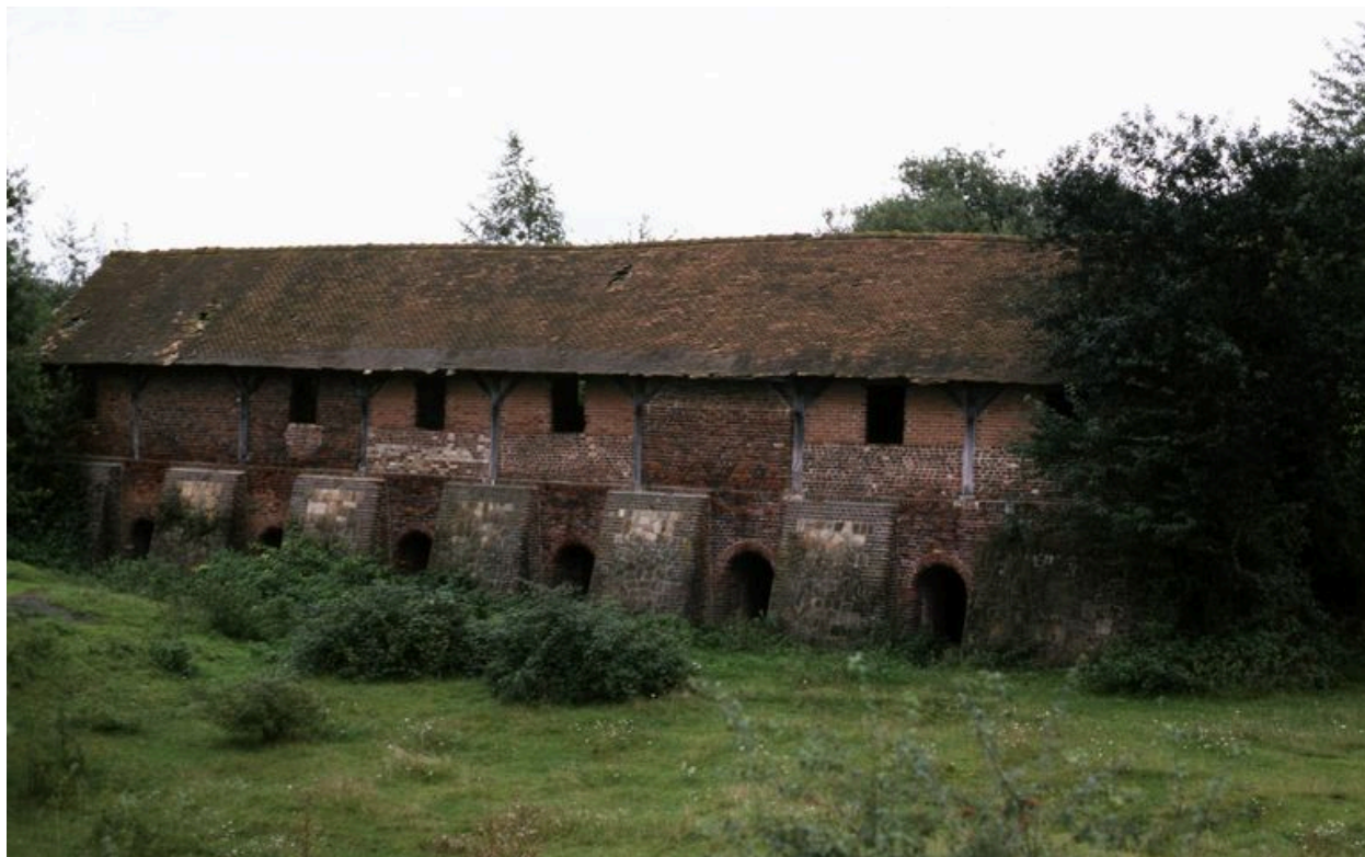
Four industriel de type Hoffmann, côté nord.
