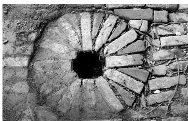
Four industriel de type Hoffmann : détail d'un des orifices à charbon (Ecomusée du Beauvaisis). Repro. Monnehay-Vulliet Marie-Laure IVR22_20106000175NUCA
