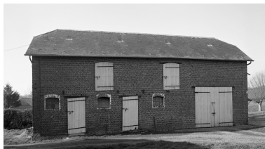
Elévation sur cour d'un bâtiment à usage d'étable, remise et fenil. Phot. Thierry Lefébure IVR22_19960200861X
