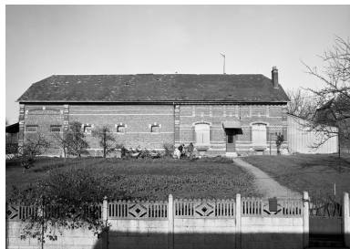
Elévation sur rue. Phot. Thierry Lefébure IVR22_19960200860X
