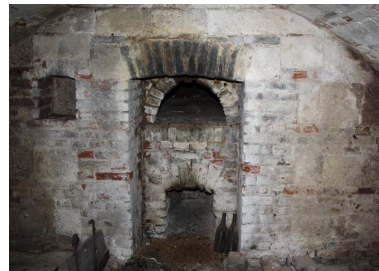
Détail du four à pain logé dans le mur de refend de la cave. Phot. Bertrand Fournier IVR22_20098005119NUCA
