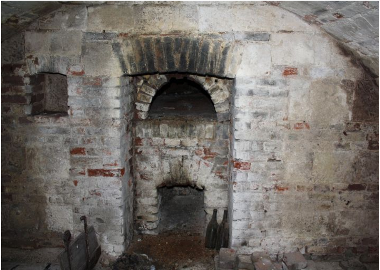
Détail du four à pain logé dans le mur de refend de la cave.
