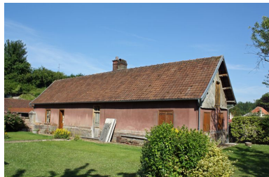
Vue d'ensemble sur jardin. Phot. Bertrand Fournier IVR22_20098005117NUCA
