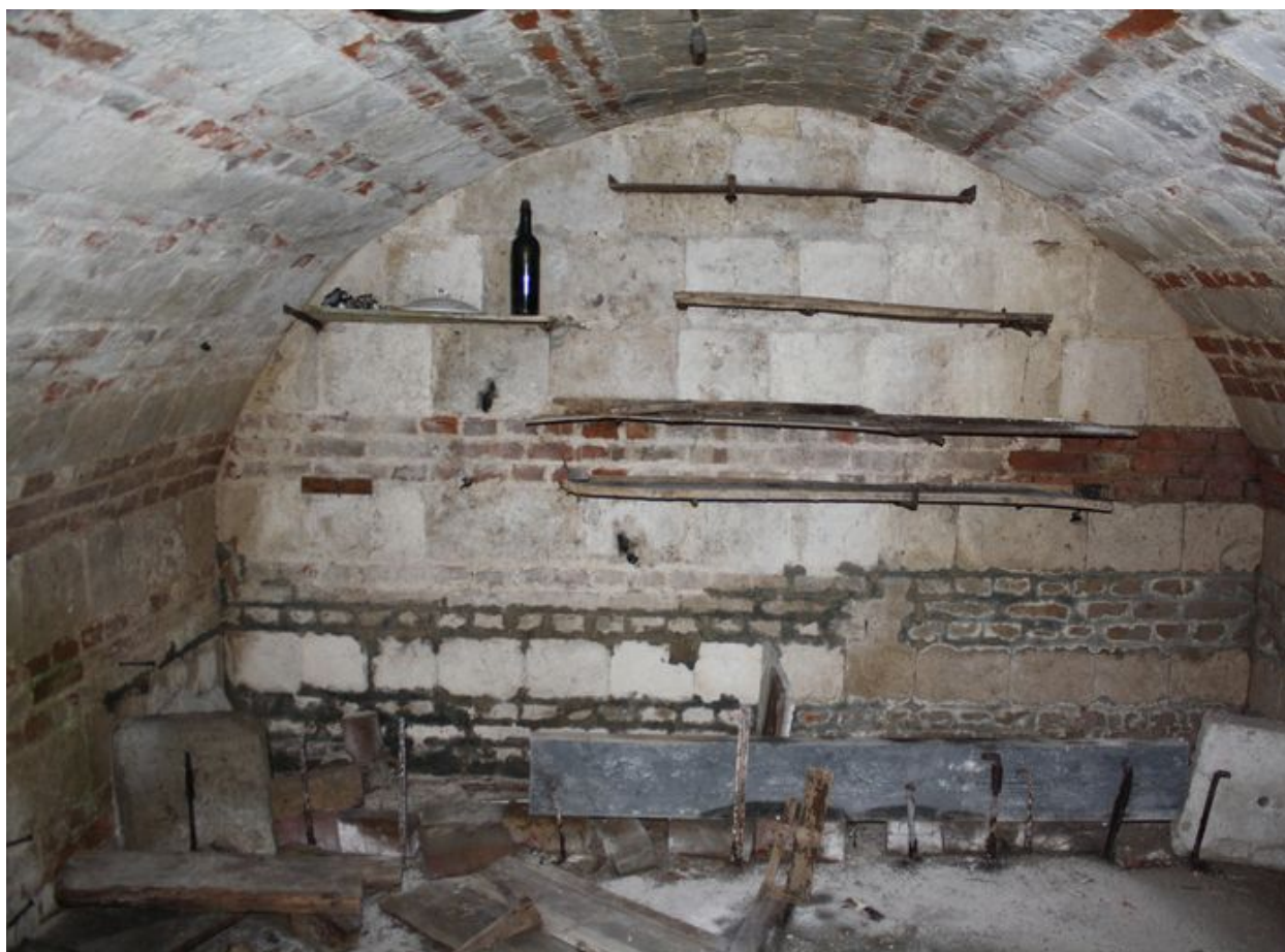
Vue intérieure de la cave voûtée en plein cintre.
