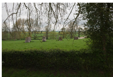
Site de lancement de V1 de Fresnoy. Plots de la rampe de lancement. Phot. Pierre Thibaut IVR31_20126201773NUCA
