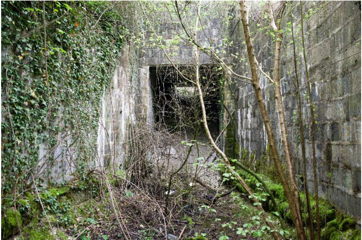
Site de lancement de V1 de Fresnoy. Vue générale d'un tunnel de stockage.
