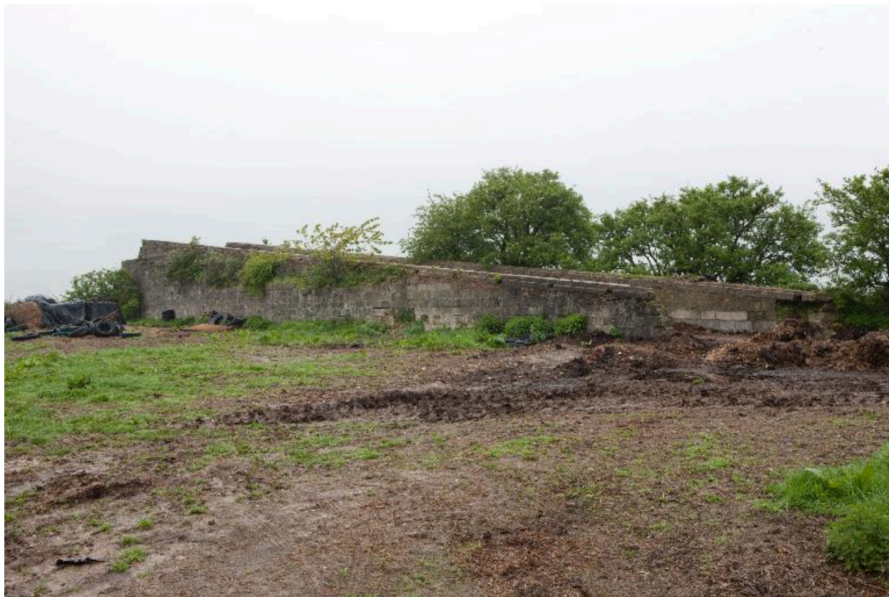
Site de lancement de V1 de Vacqueriette-Erquières. Murs de protection de la rampe de lancement.
