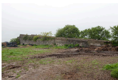
Site de lancement de V1 de Vacqueriette-Erquières. Murs de protection de la rampe de lancement. Phot. Pierre Thibaut IVR31_20126201653NUCA
