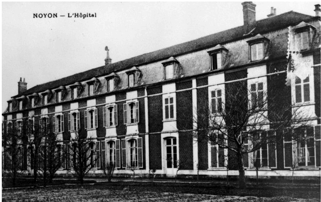
Bâtiment du 19e siècle, avant 1914 (AP).
