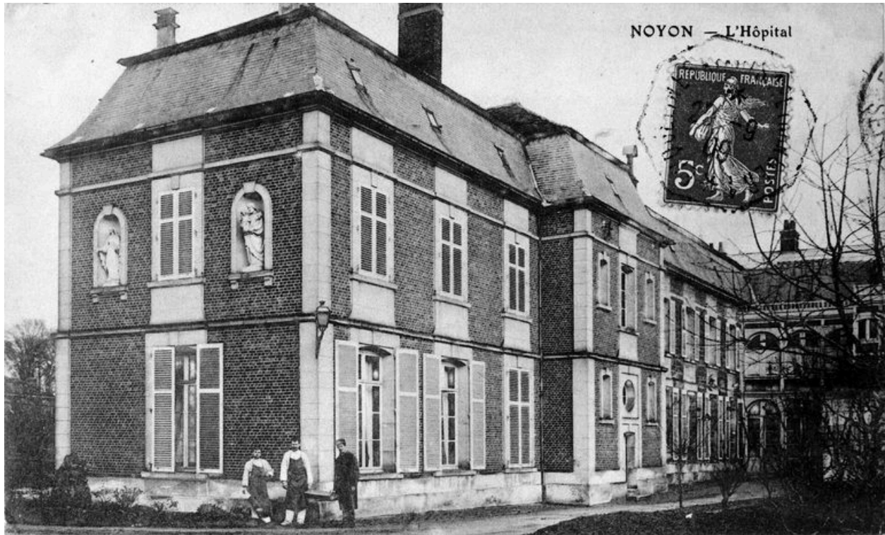
Bâtiment du 19e siècle, avant 1914 (AP).
