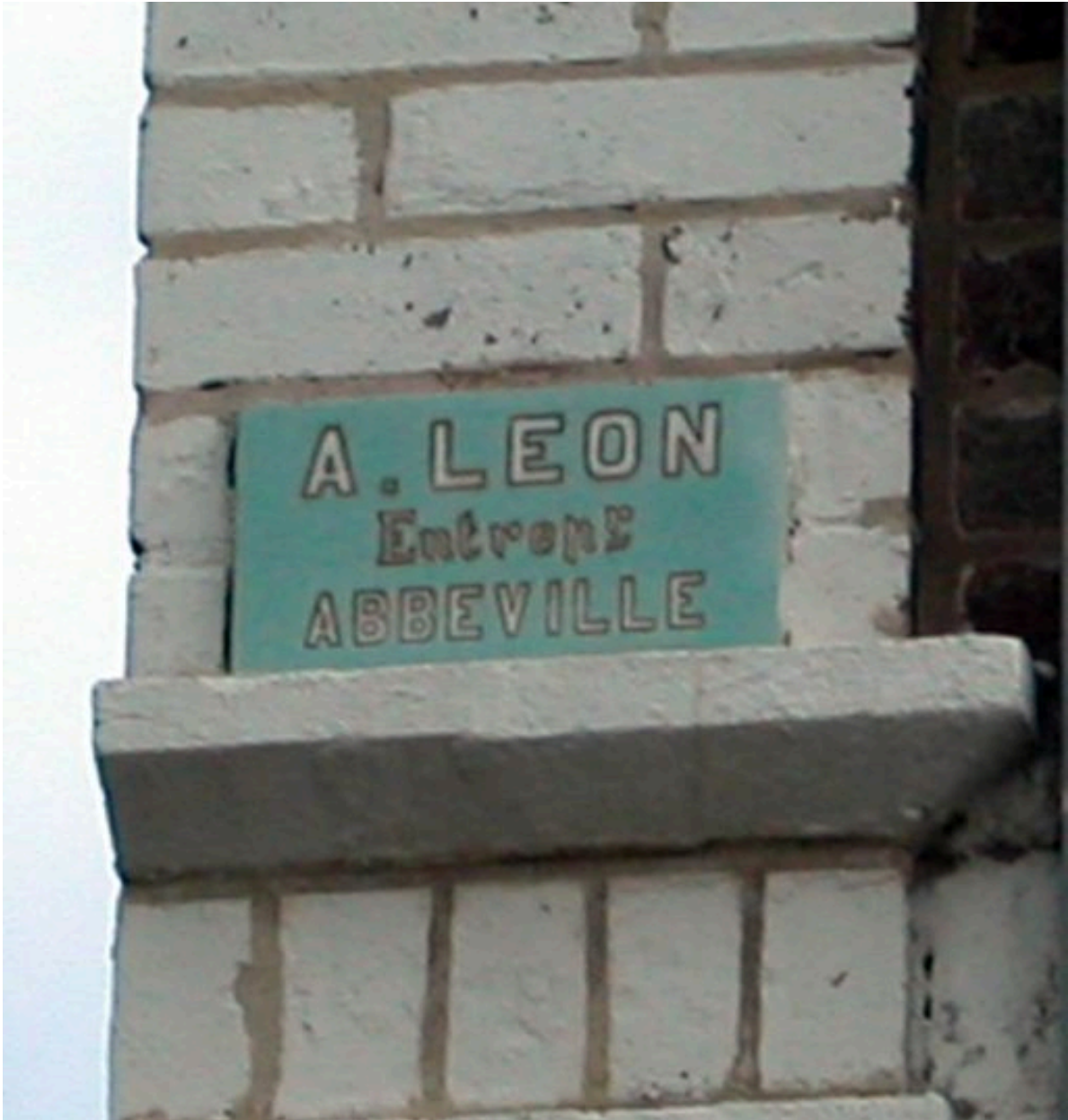
Détail du carreaux de céramique portant signature du maître d'oeuvre.
