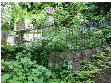
Vue générale, depuis l'allée méridionale. Phot. Caroline Vincent IVR22_20098001184NUCA
