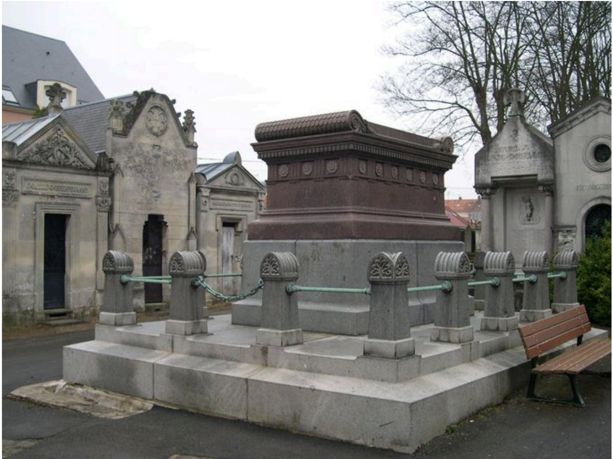
Vue générale, depuis le nord-ouest.
