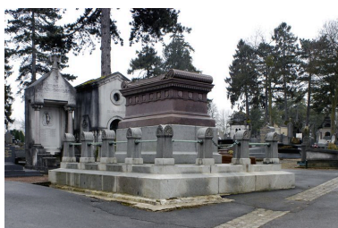
Vue de situation, depuis le nord-est. Phot. Thierry Lefébure IVR22_20058000380NUCA
