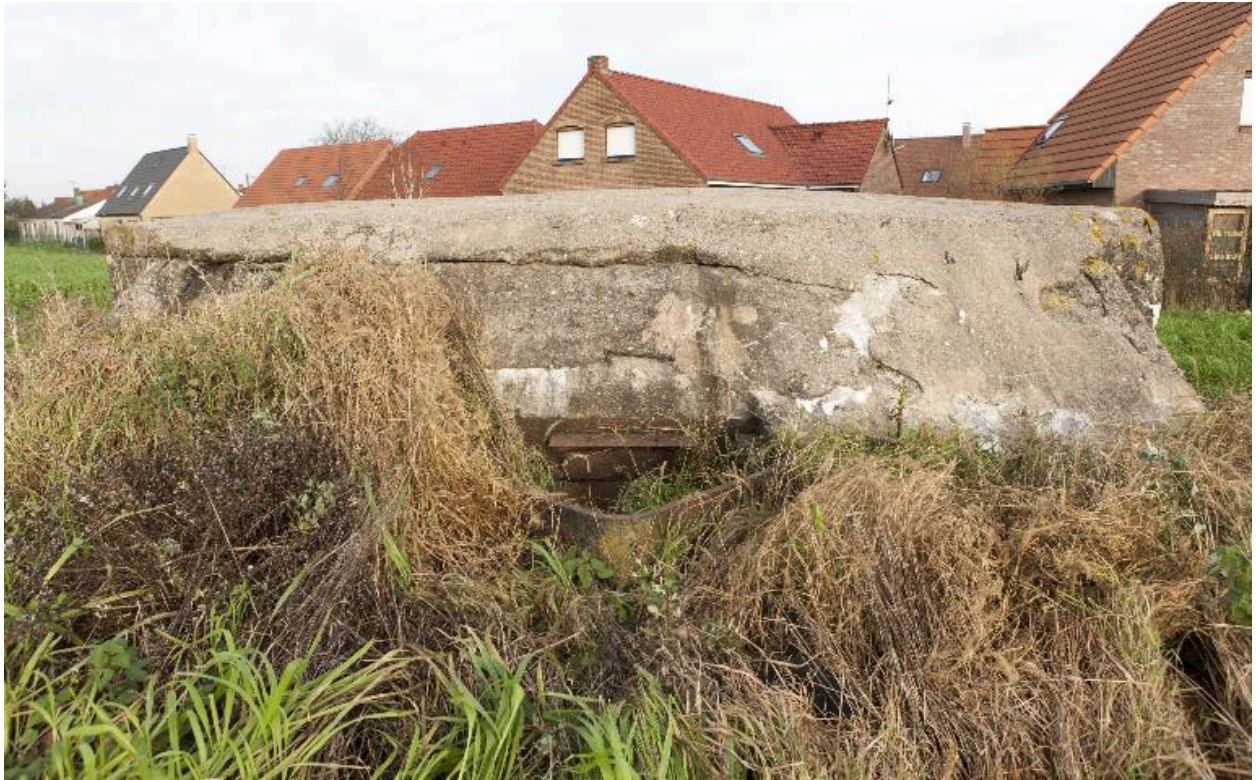
Vue frontale, vers le nord-est. Au milieu, l'observatoire cuirassé (endommagé)
