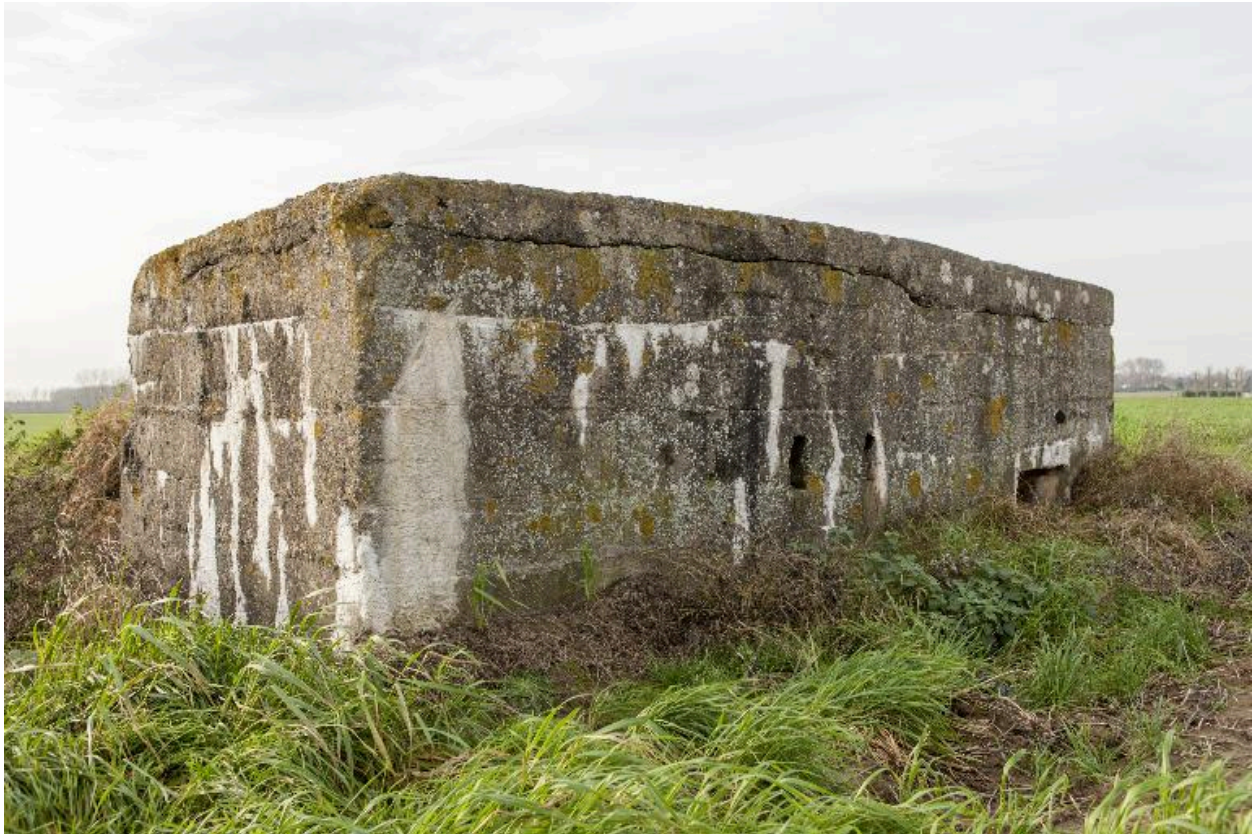
Vue de trois-quarts arrière, vers l'ouest
