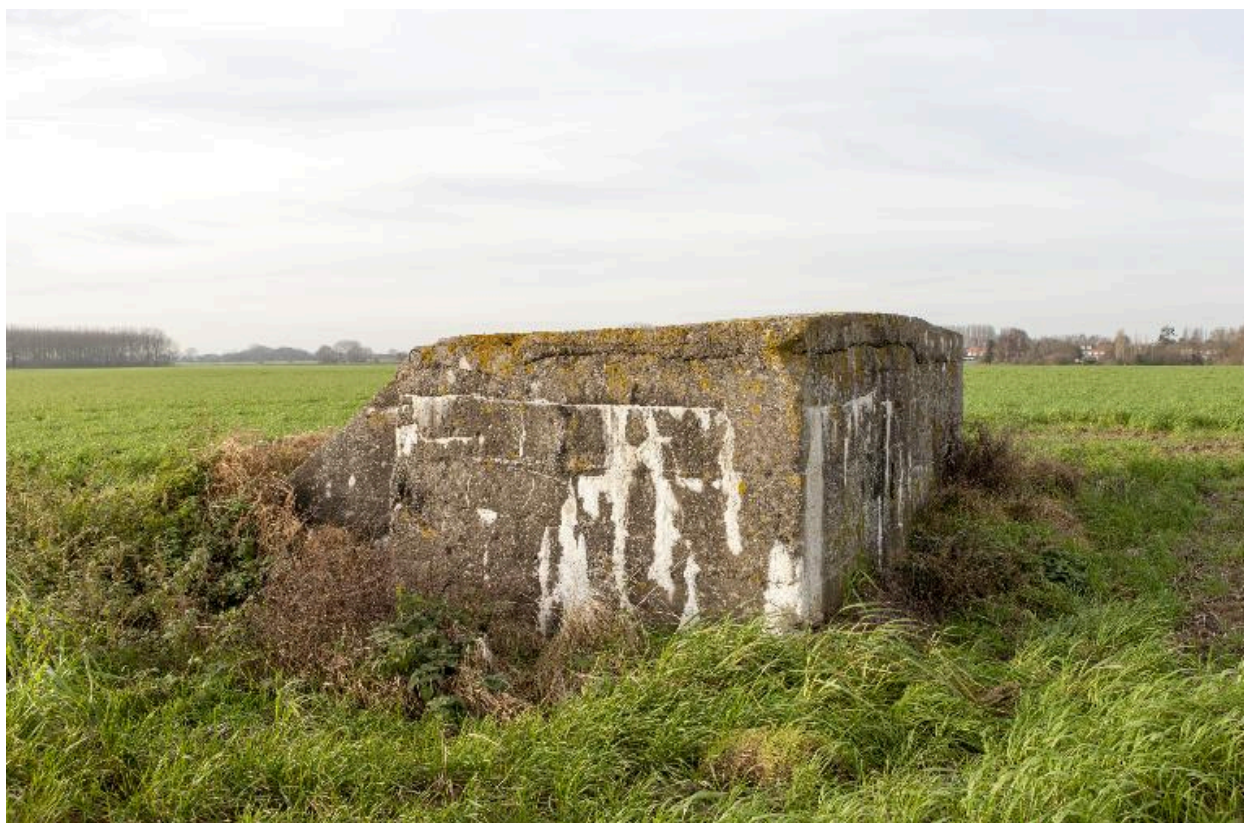
Vue de trois-quarts vers le nord-ouest
