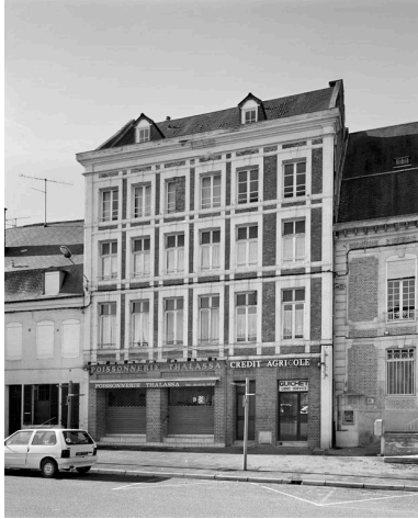
Vue de la façade sur rue. Phot. Thierry Lefébure IVR22_20020200821V
