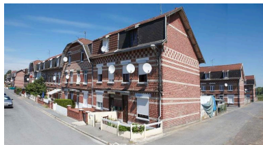
Vue générale de la cité. Phot. Hubert Bouvet IVR31_20105900349NUCA
