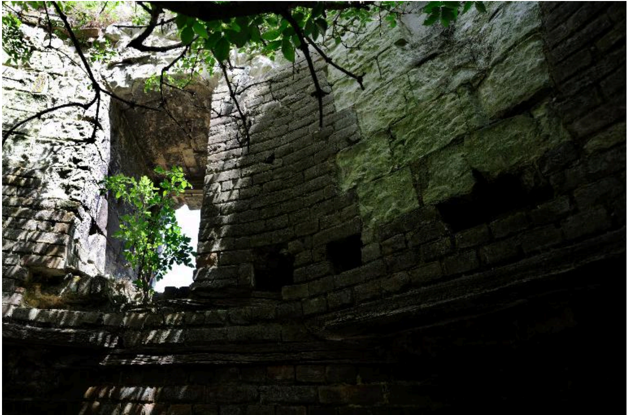
Détail de l'élévation intérieure, deuxième niveau.
