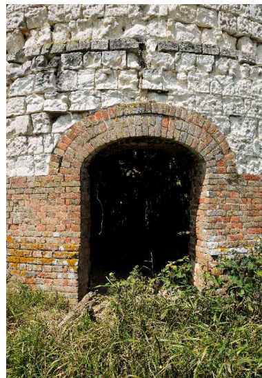
Porte principale. Phot. Marie-Laure Monnehay-Vulliet IVR22_20128000741NUC2A
