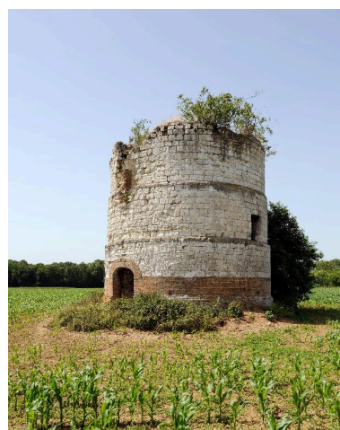
Vue générale depuis l'est. Phot. Marie-Laure Monnehay-Vulliet IVR22_20128000739NUC2A
