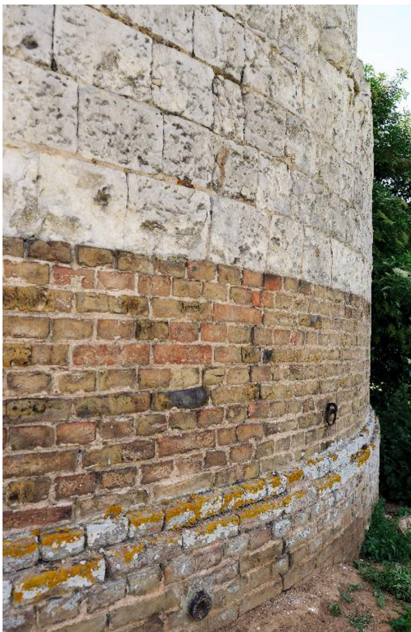
Détail de l'appareil du mur : pierre de taille et solin de brique.
