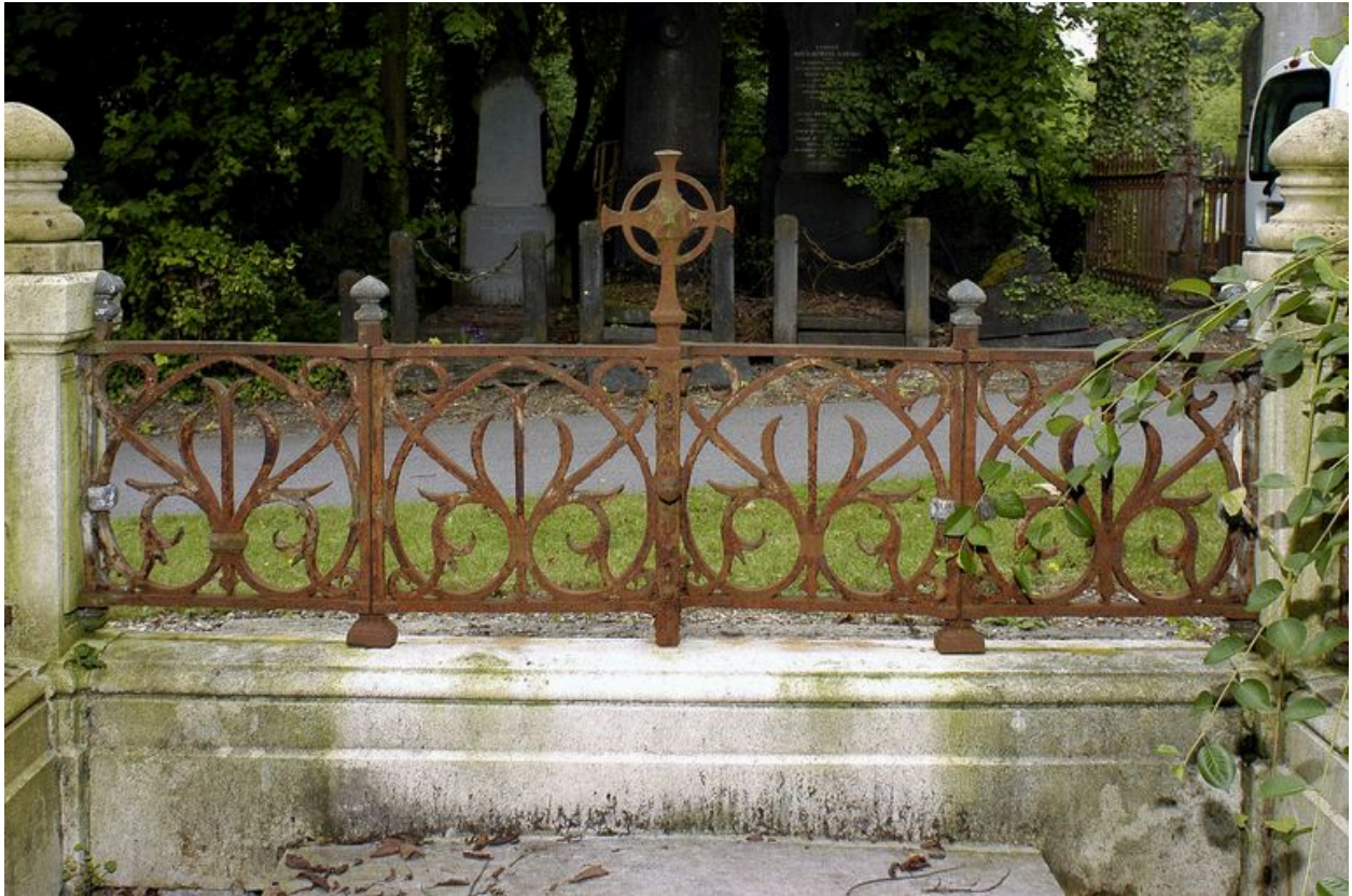
Détail de la clôture.
