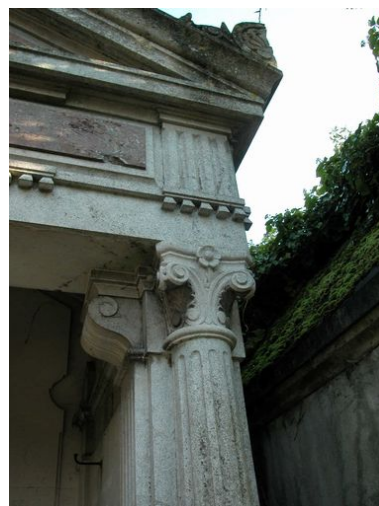
Détail de l'entablement. Phot. Laurent Nicolas IVR22_20048001306NUCA
