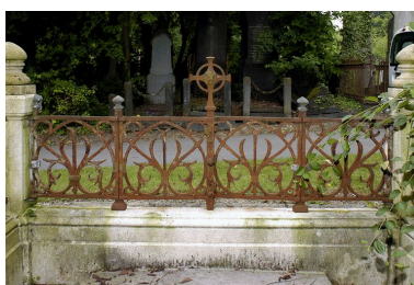
Détail de la clôture. Phot. Thierry Lefébure IVR22_20058001344NUCA
