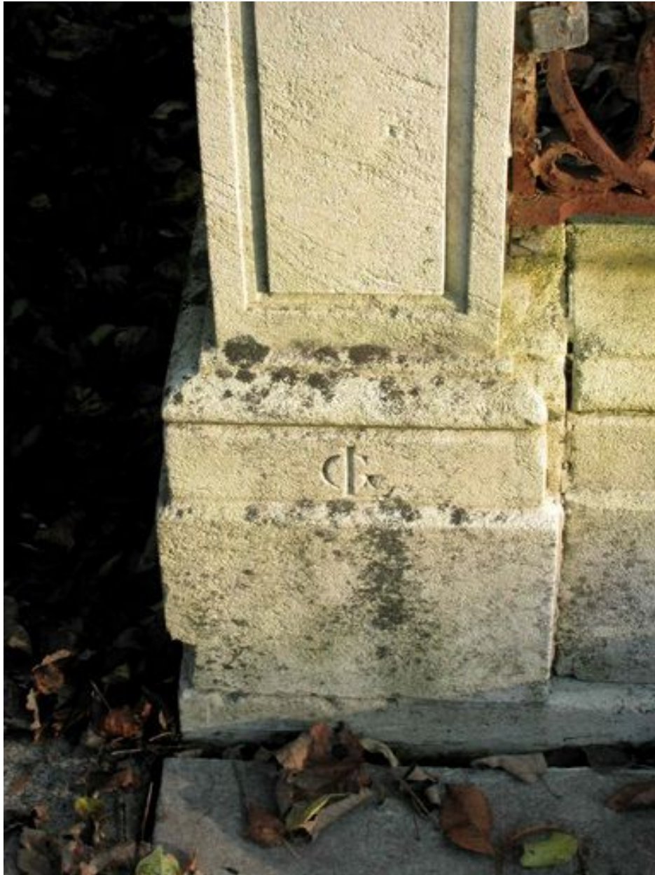
Détail du pilier gauche de la clôture.
