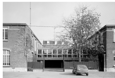
Ateliers de fabrication, logement patronal, élévation antérieure. Phot. Olivier Marlard IVR31_19885902195X
