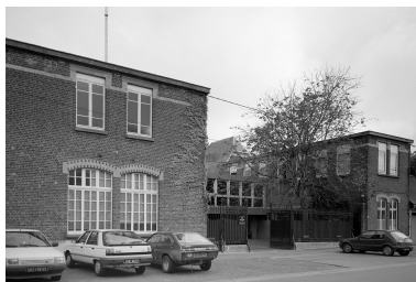
Ateliers de fabrication, élévation antérieure. Phot. Olivier Marlard IVR31_19885902196X
