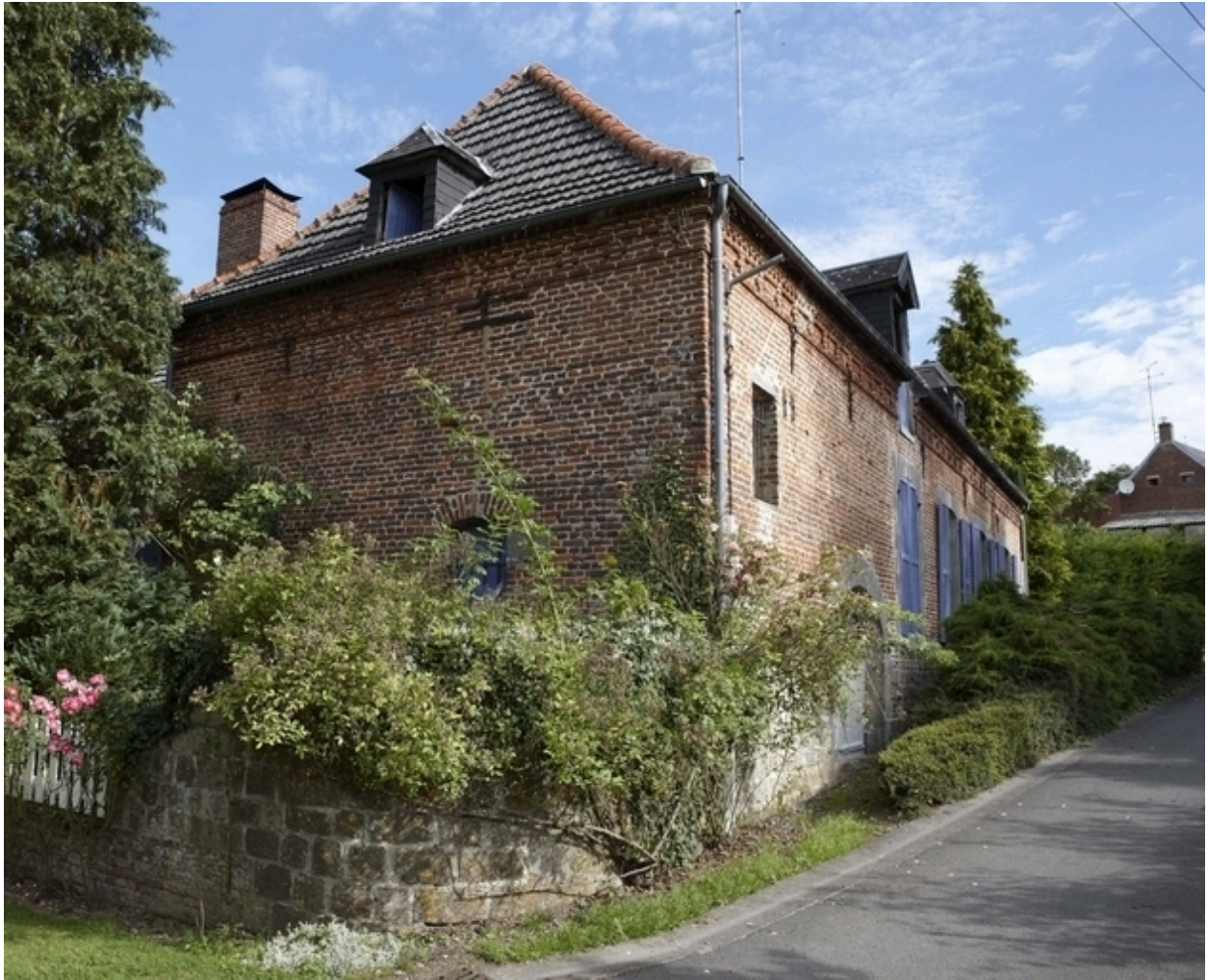
Vue du pignon sud du moulin.
