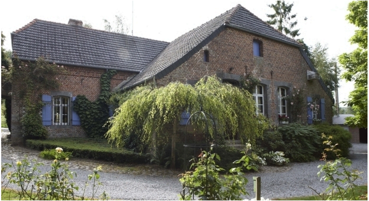
Vue de l'élévation sur cour.
