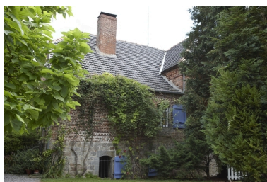
Vue du pignon sud du second volume. Phot. Pierre Thibaut IVR31_20095902658NUCA
