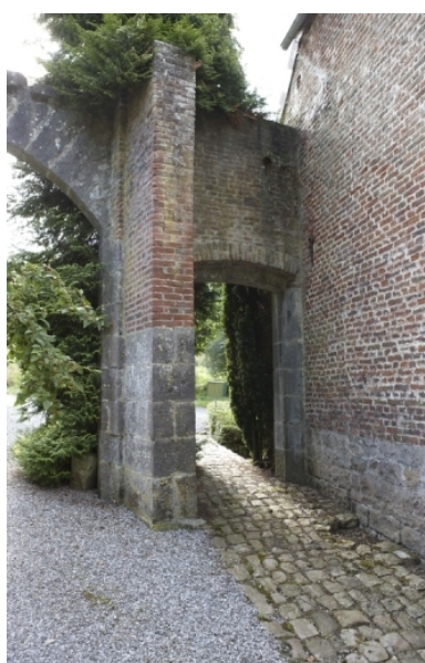
Détail de l'entrée pavée de grès, aménagée entre le porche et le moulin.
