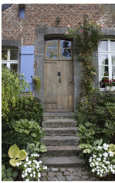
Détail de la porte d'entrée sur cour. Phot. Pierre Thibaut IVR31_20095902639NUCA
