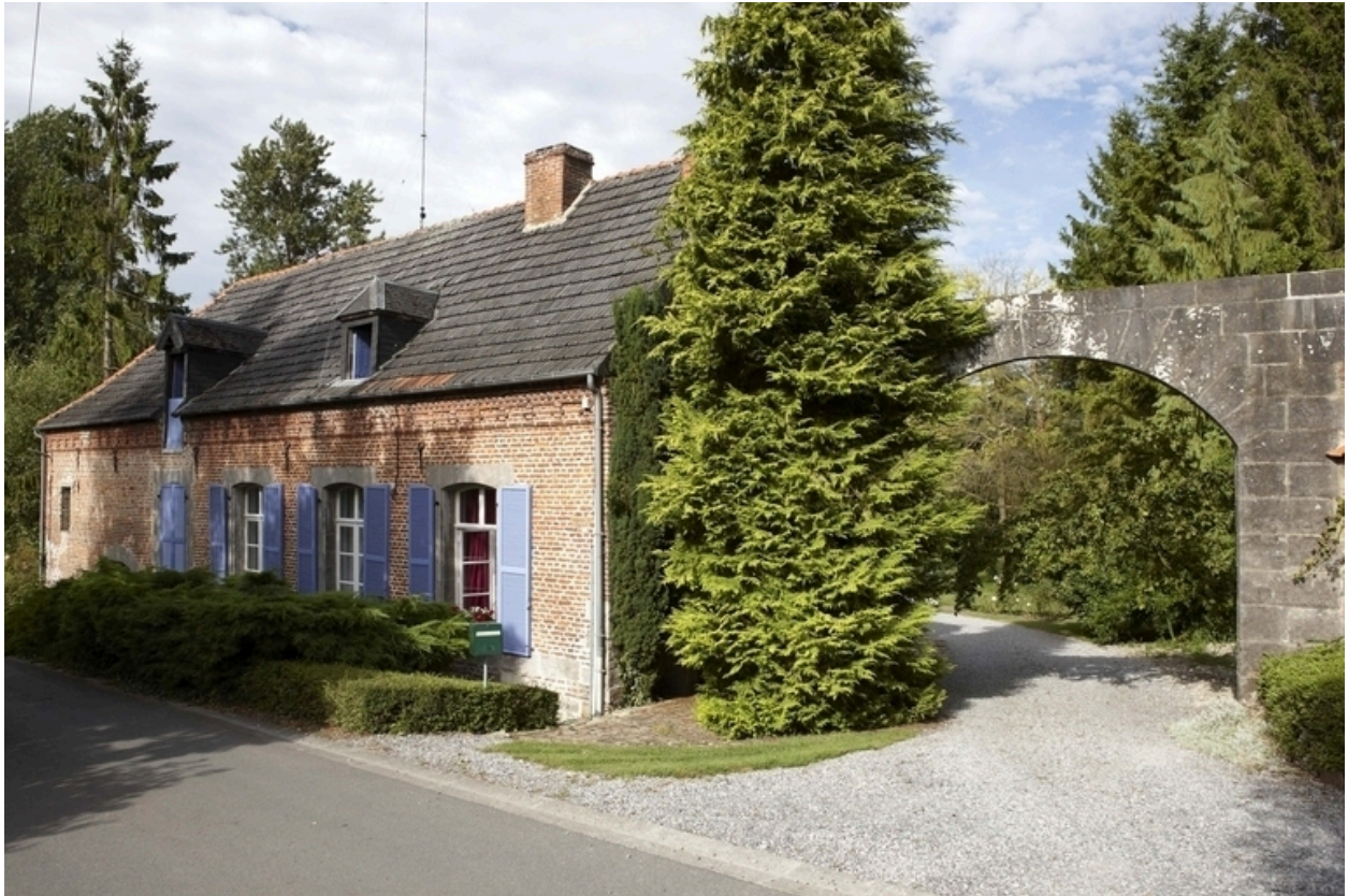
Vue du moulin et du porche.
