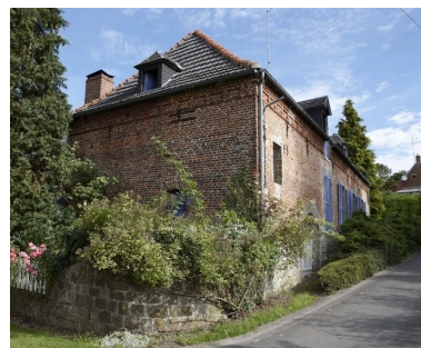
Vue du pignon sud du moulin. Phot. Pierre Thibaut IVR31_20095902636NUCA
