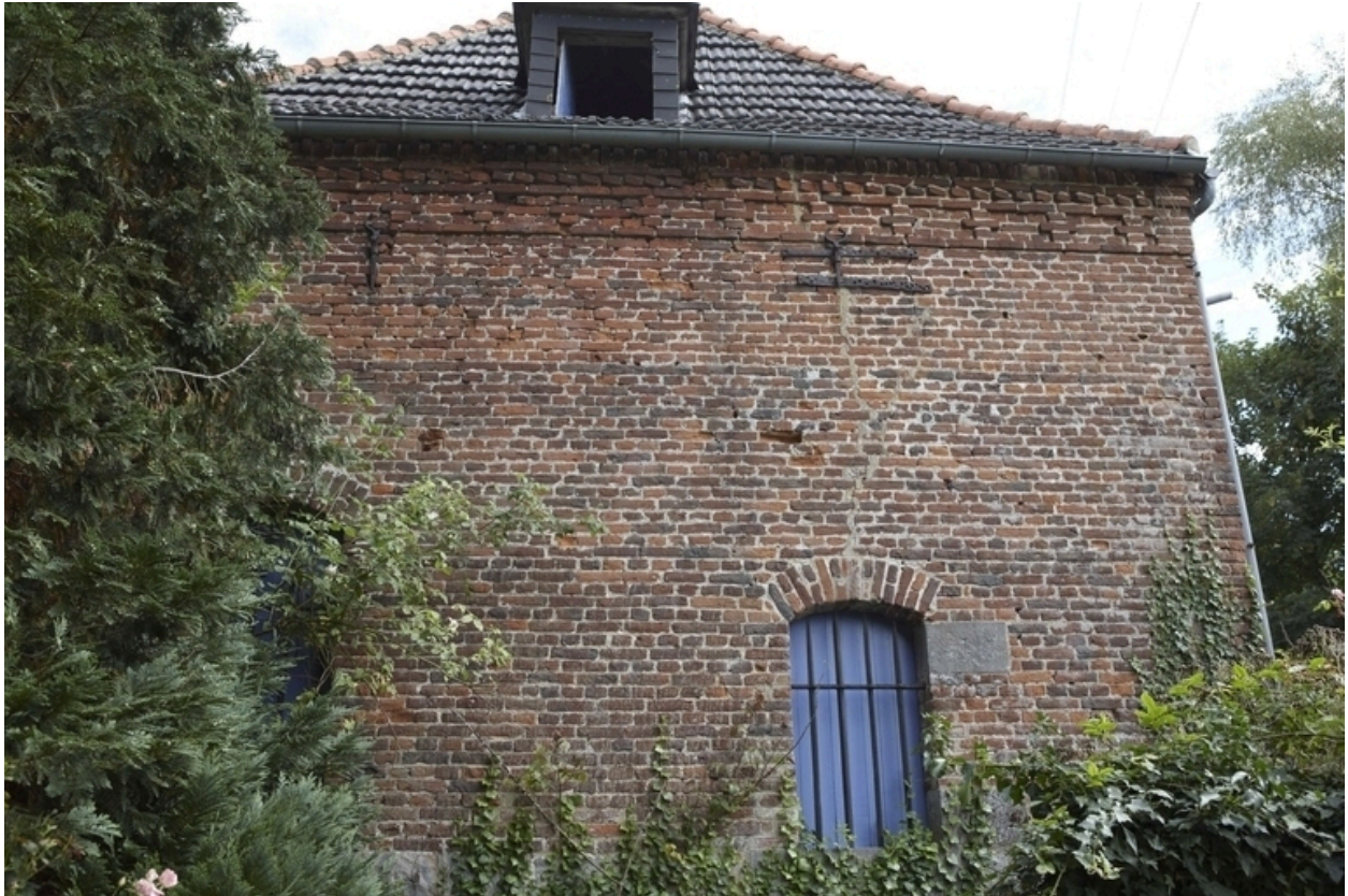
Détail du pignon sud.
