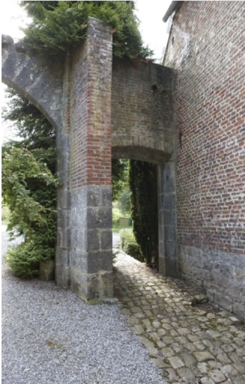
Détail de l'entrée pavée de grès, aménagée entre le porche et le moulin.
