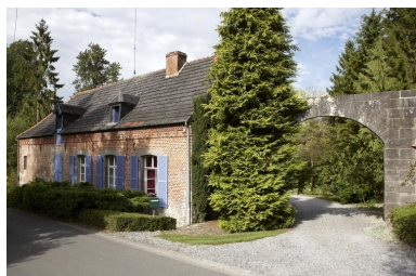
Vue du moulin et du porche. Phot. Pierre Thibaut IVR31_20095902634NUCA
