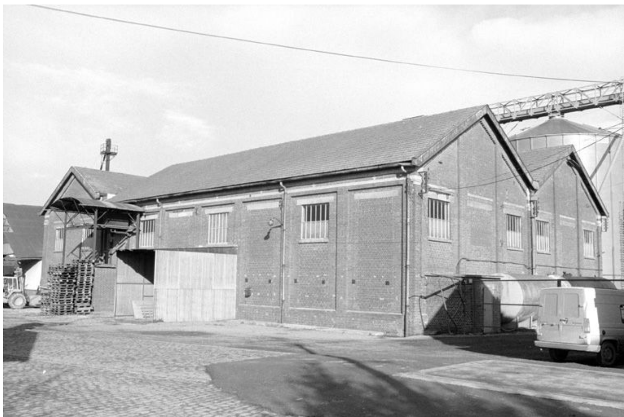
Atelier de fabrication, vue partielle.
