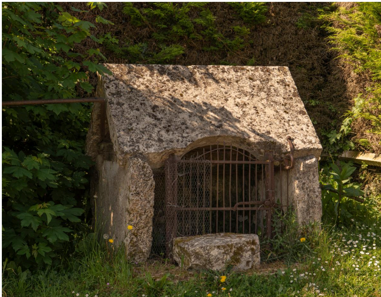
Puits en pierre, Grande Rue, vue depuis le nord.
