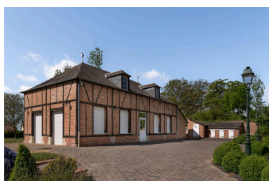
Ancien presbytère, aujourd'hui mairie, rue de l'Église, vue depuis le nord-est. Phot. Marc Kérignard IVR32_20226000313NUCA
