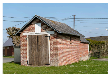
Remise des pompes à incendie, vue depuis l'ouest. Phot. Marc Kérignard IVR32_20226000215NUCA
