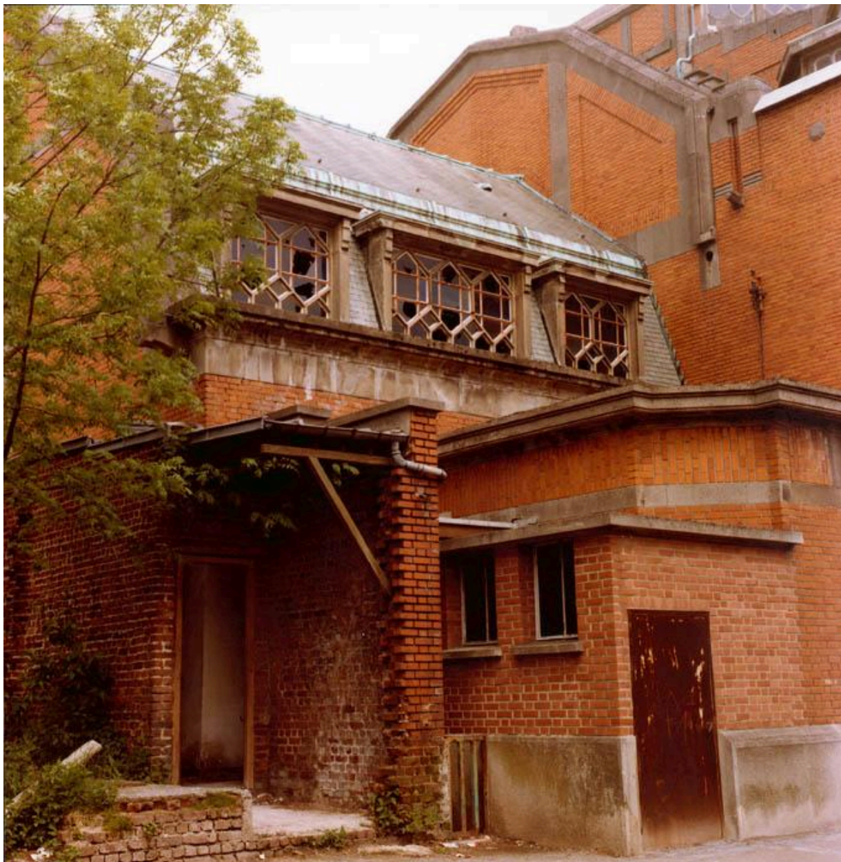
Vue partielle de trois quarts du chevet (?), avant sa destruction. Photographie, photographe inconnu, circa 1985-1986 (AC Aulnoye-Aymeries).
