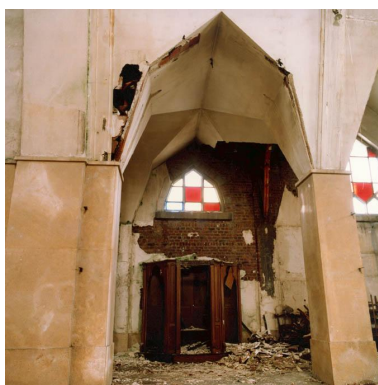
Vue intérieure, état de dégradation de la troisième travée du bas côté occidental, avant sa destruction. Photographie, photographe inconnu, circa 1985-1986 (AC Aulnoye-Aymeries). Repro. Eddy Stein IVR31_20015901549NUCB
