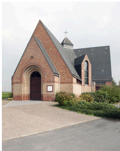
Élévation antérieure et flanc est. Phot. Pierre Thibaut IVR31_20155900798NUCA
