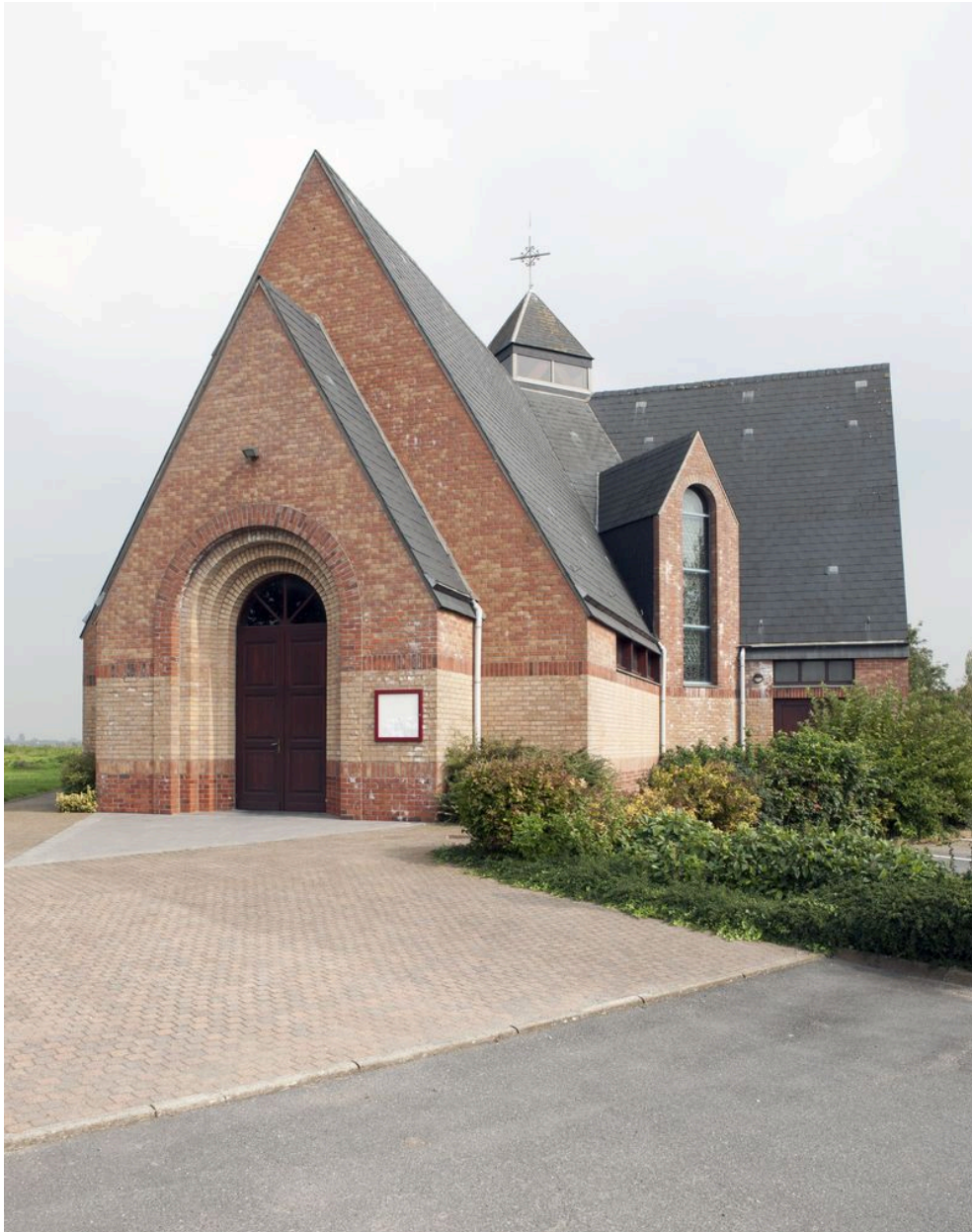
Élévation antérieure et flanc est.
