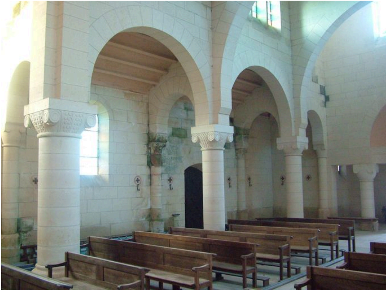
Vue du bas-côté sud.
