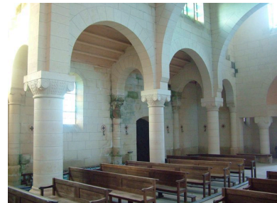
Vue du bas-côté sud. Phot. Inès Guérin IVR22_20050200317NUCA
