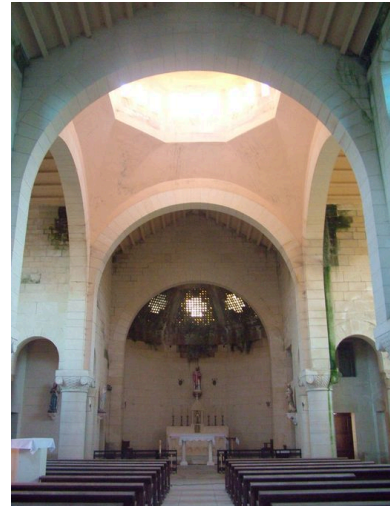
Vue intérieure. Phot. Inès Guérin IVR22_20050200313NUCA
