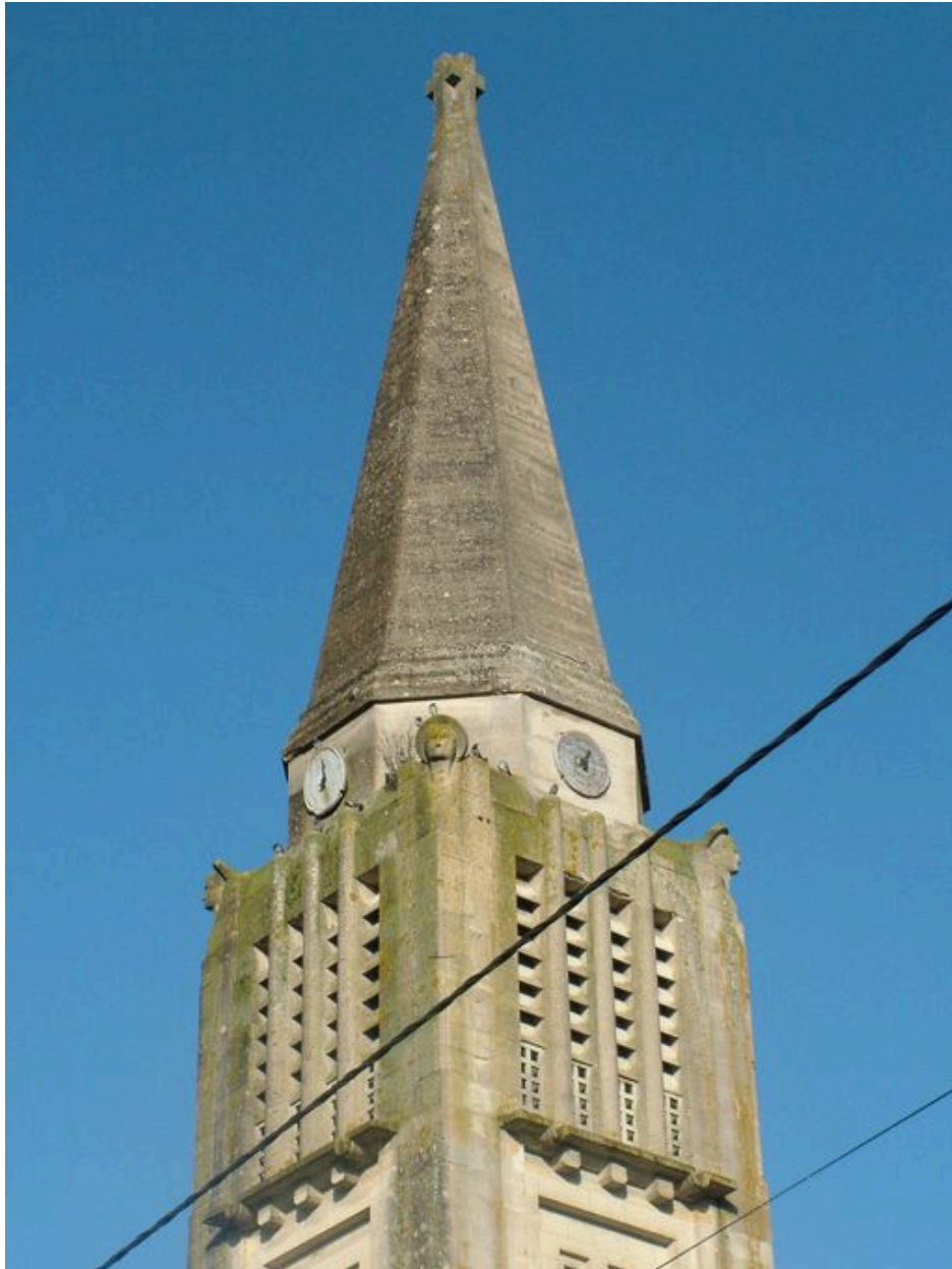
Vue détaillée du clocher.
