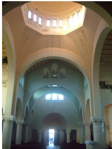
Vue partielle de la coupole et de la charpente. Phot. Inès Guérin IVR22_20050200315NUCA
