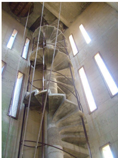
Vue de l'escalier en béton armé permettant l'accès au sommet du clocher. Phot. Inès Guérin IVR22_20050200319NUCA
