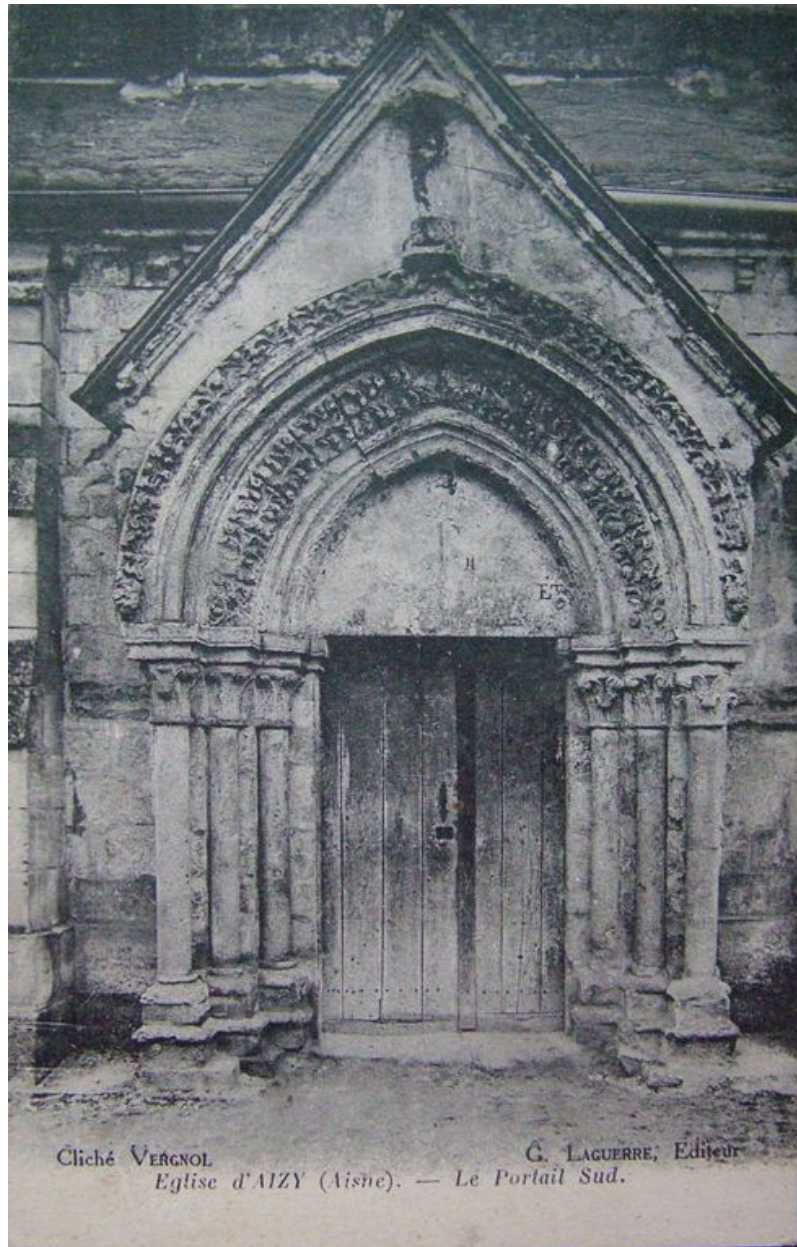
Vue ancienne du portail sud (coll. part).
