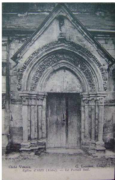
Vue ancienne du portail sud (coll. part).
