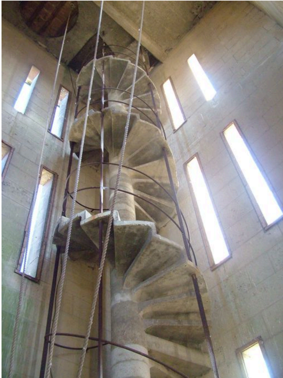
Vue de l'escalier en béton armé permettant l'accès au sommet du clocher.
