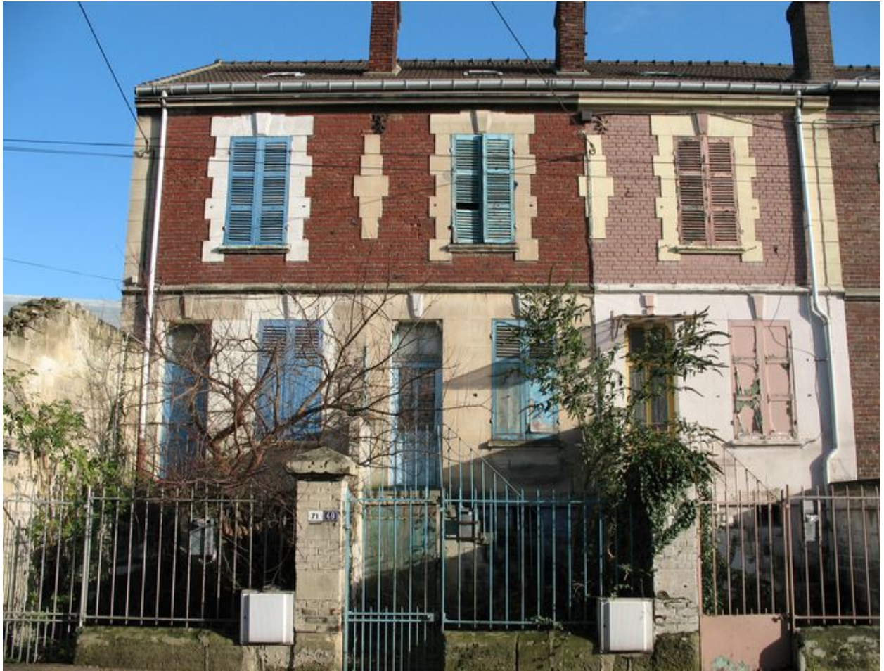
Détail de trois travées de la barre de logements.
