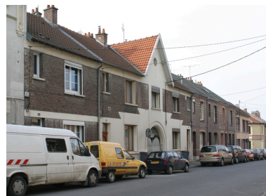
Façade antérieure sur rue. Phot. Frédéric Pillet IVR22_20060205105NUCA
