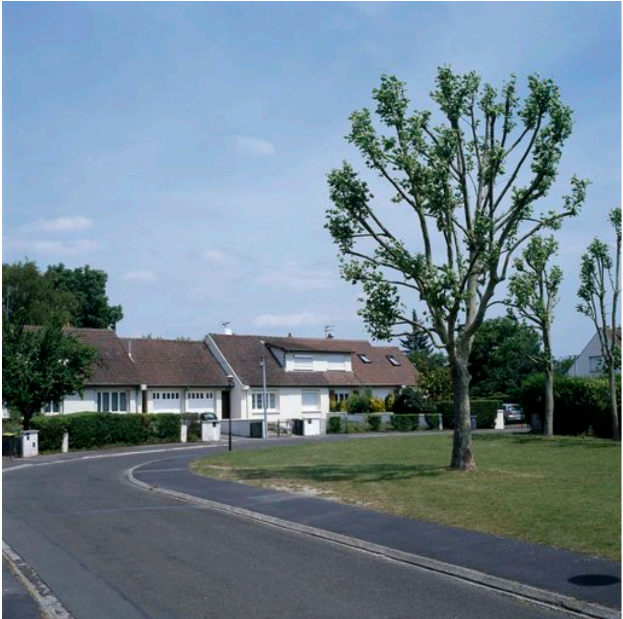
Maisons jumelées de la cité du Bas-Mettemont.
