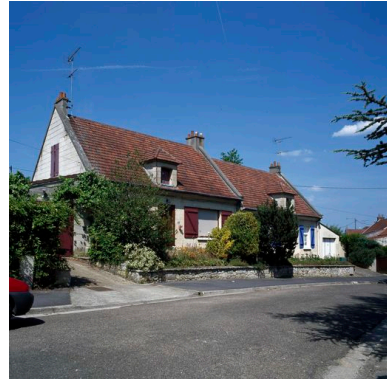
Maisons de la cité du Bas-Mettemont. Phot. Thierry Lefébure IVR22_20106000778XA
