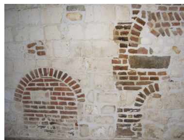
Vue des fours secondaires, aujourd'hui condamnés. Phot. Inès Guérin IVR22_20068005563NUCA
