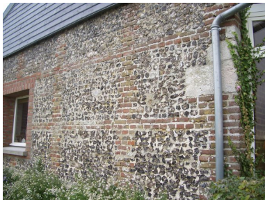
Vue de la maçonnerie des écuries au sud du logis. Phot. Inès Guérin IVR22_20068005557NUCA
