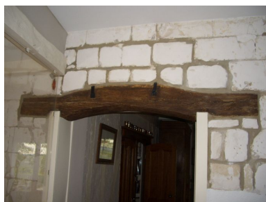
Vue de l'un des linteaux des ouvertures du logis. Phot. Inès Guérin IVR22_20068005558NUCA
