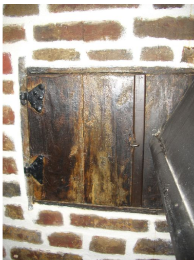
Vue de la niche située près du foyer destinées à la conservation des denrées craignant l'humidité (telles que le sel, les livres, le tabac). Phot. Inès Guérin IVR22_20068005560NUCA
