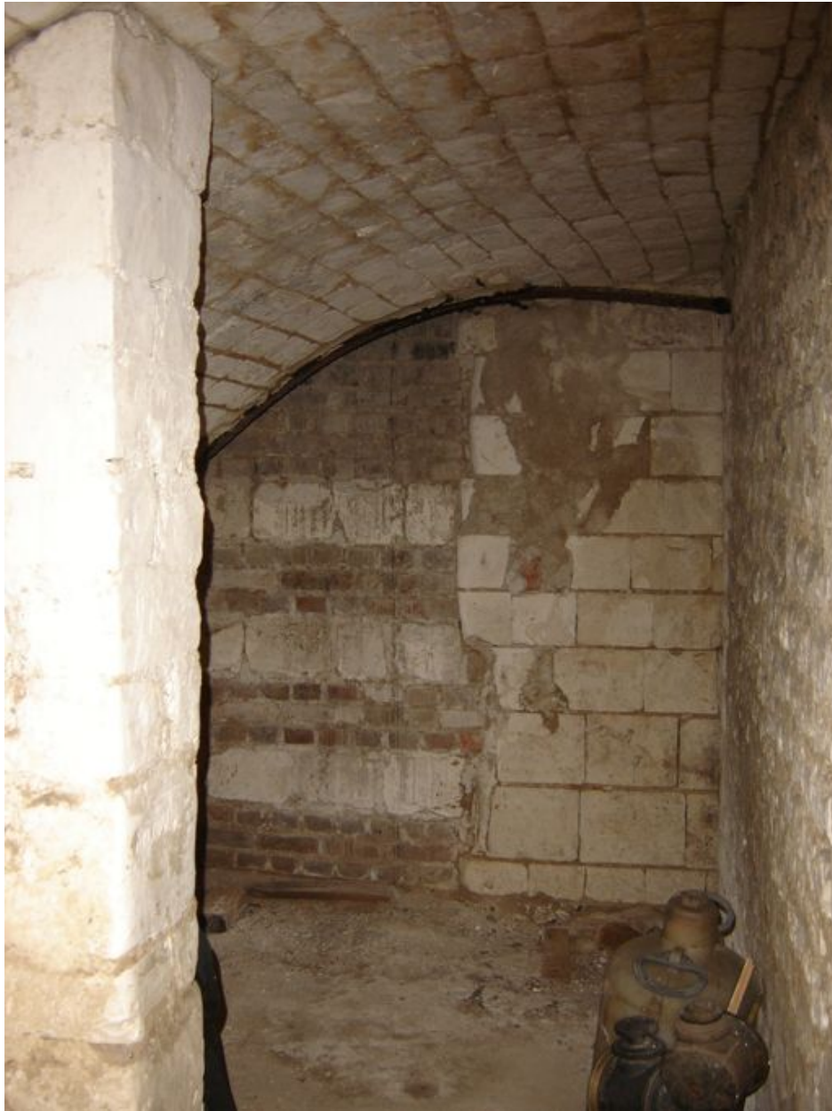
Vue partielle de la cave voûtée en pierre de taille.
