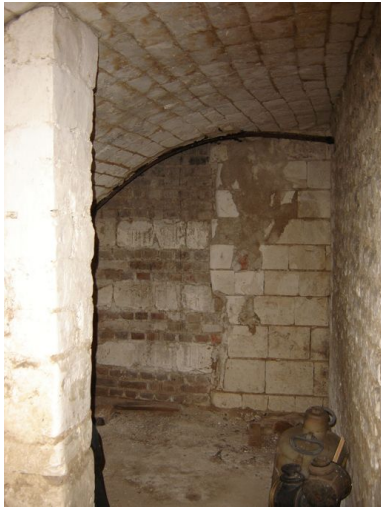
Vue partielle de la cave voûtée en pierre de taille. Phot. Inès Guérin IVR22_20068005566NUCA
