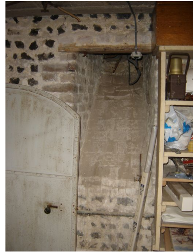
Système d'aération de la cave. Phot. Inès Guérin IVR22_20068005569NUCA
