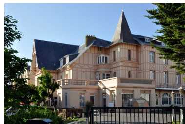
Vue générale, élévation rue Eugène-Trigoulet, en 2010.
