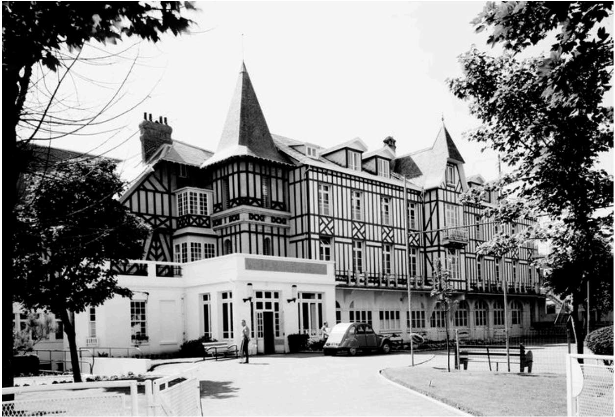
Vue générale, élévation rue Eugène-Trigoulet, en 1981.
