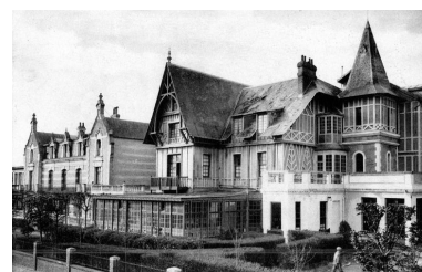
Elévation donnant sur la rue de Lhomel, avec l'ancienne villa, au premier plan sur la droite, et le bâtiment ajouté en 1906-1907, au second plan sur la gauche, vue d'ensemble prise de trois-quarts droit. Carte postale (coll. part.). Phot. Stein Eddy IVR31_20066200344NUC
