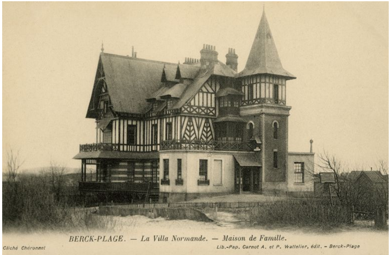
Ancienne villa, état avant ses agrandissements successifs, vue générale. Carte postale, vers 1900 (coll. part.).
