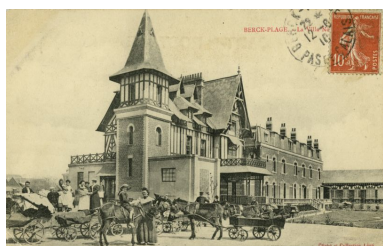
Ancienne villa avec, dans son prolongement sur l'arrière, le bâtiment ajouté en 1906-1907 le long de la rue Lhomel, vue générale (coll. part.). Phot. Bouvet Hubert IVR31_20146202320NUC
