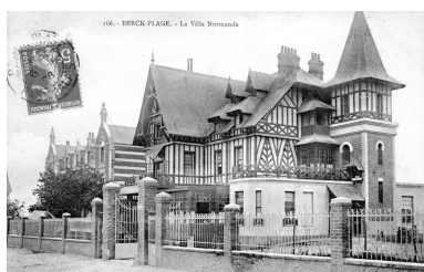
Elévation donnant sur la rue, vue générale. Carte postale, vers 1910 (coll. part.). Phot. Stein Eddy IVR31_20066200131NUC
