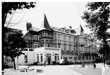
Vue générale, élévation rue Eugène-Trigoulet, en 1981.
