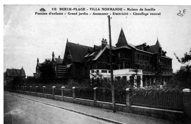
Vue générale prise depuis la rue de Lhomel montrant l'état de la villa après le second agrandissement parallèlement à la rue Eugène-Trigoulet (coll. part.). Phot. Thibaut Pierre (reproduction) IVR31_20066200451NUC
