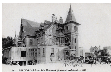
Elévation donnant sur la rue de Lhomel, avec l'ancienne villa, au premier plan sur la droite, et le bâtiment ajouté en 1906-1907, tout à fait à l'arrière-plan sur la gauche dont on voit un pignon. Carte postale (coll. part.). Phot. Thibaut Pierre (reproduction) IVR32_20166200005NUC
