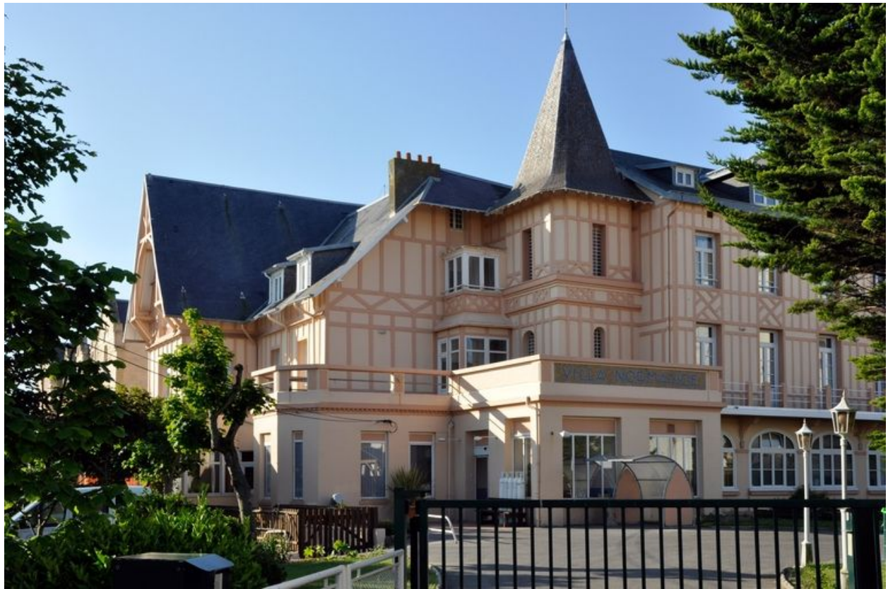
Vue générale, élévation rue Eugène-Trigoulet, en 2010.
