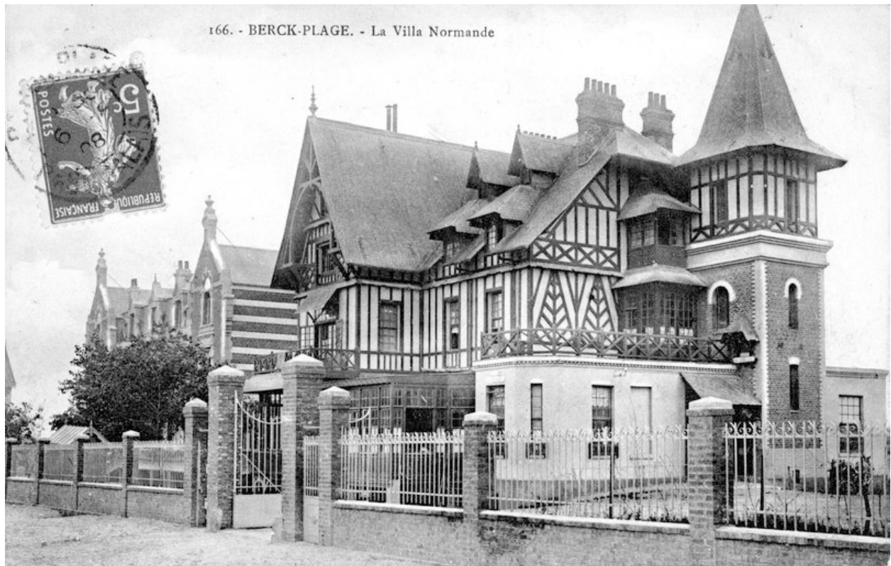
Elévation donnant sur la rue, vue générale. Carte postale, vers 1910 (coll. part.).
