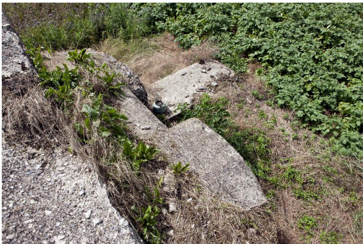
Vue de dessus du porche pare-souffle
