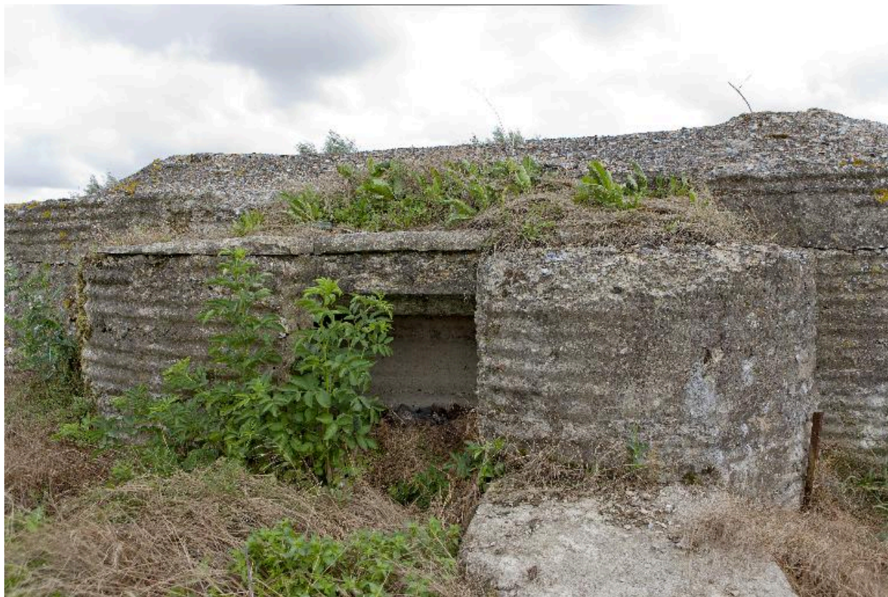
Entrée, vers le sud-est
