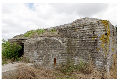
Porche pare-souffle d'entrée Phot. Jean-Marc Ramette IVR31_20146203024NUCA
