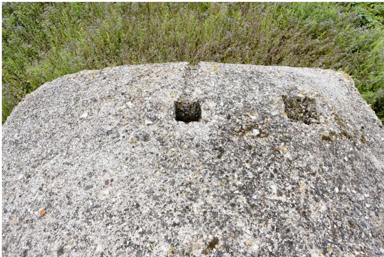
Partie sud-ouest du couverture avec aération et/ou cheminée périscopique
