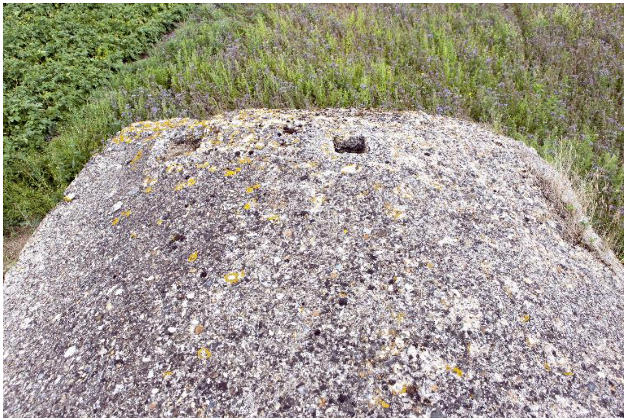
Partie nord-est du couvrement avec aération et/ou cheminée périscopique
