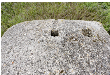
Partie sud-ouest du couvrement avec aération et/ou cheminée périscopique Phot. Jean-Marc Ramette IVR31_20146203029NUCA
