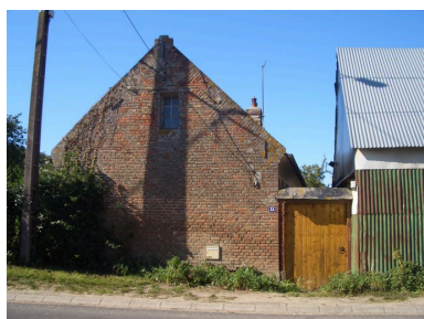
Vue du pignon nord en brique.
