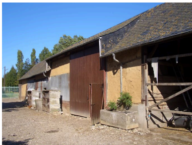
Vue de la partie centrale de la grange. Phot. Inès Guérin IVR22_20068005272NUCA
