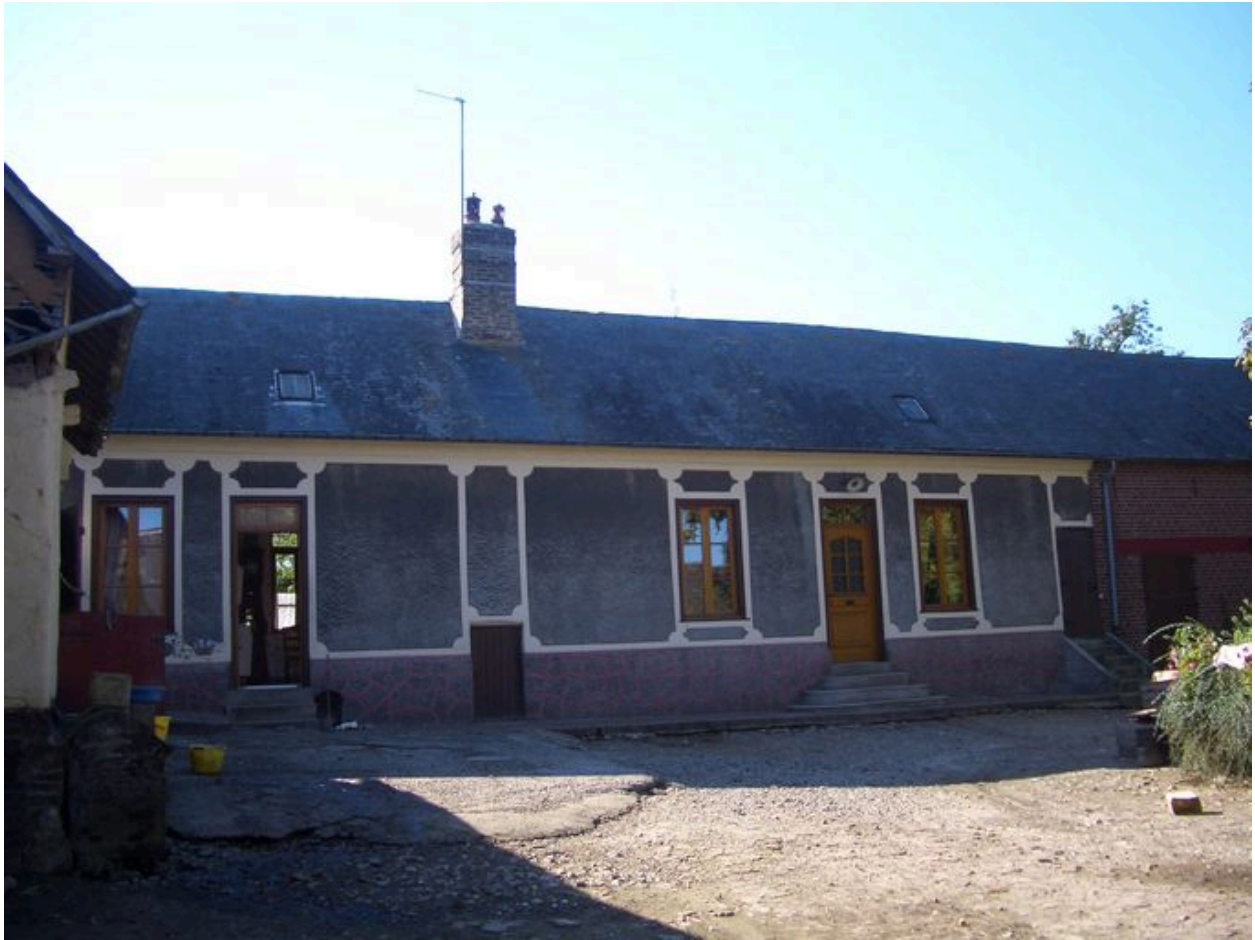
Façade principale du logis.
