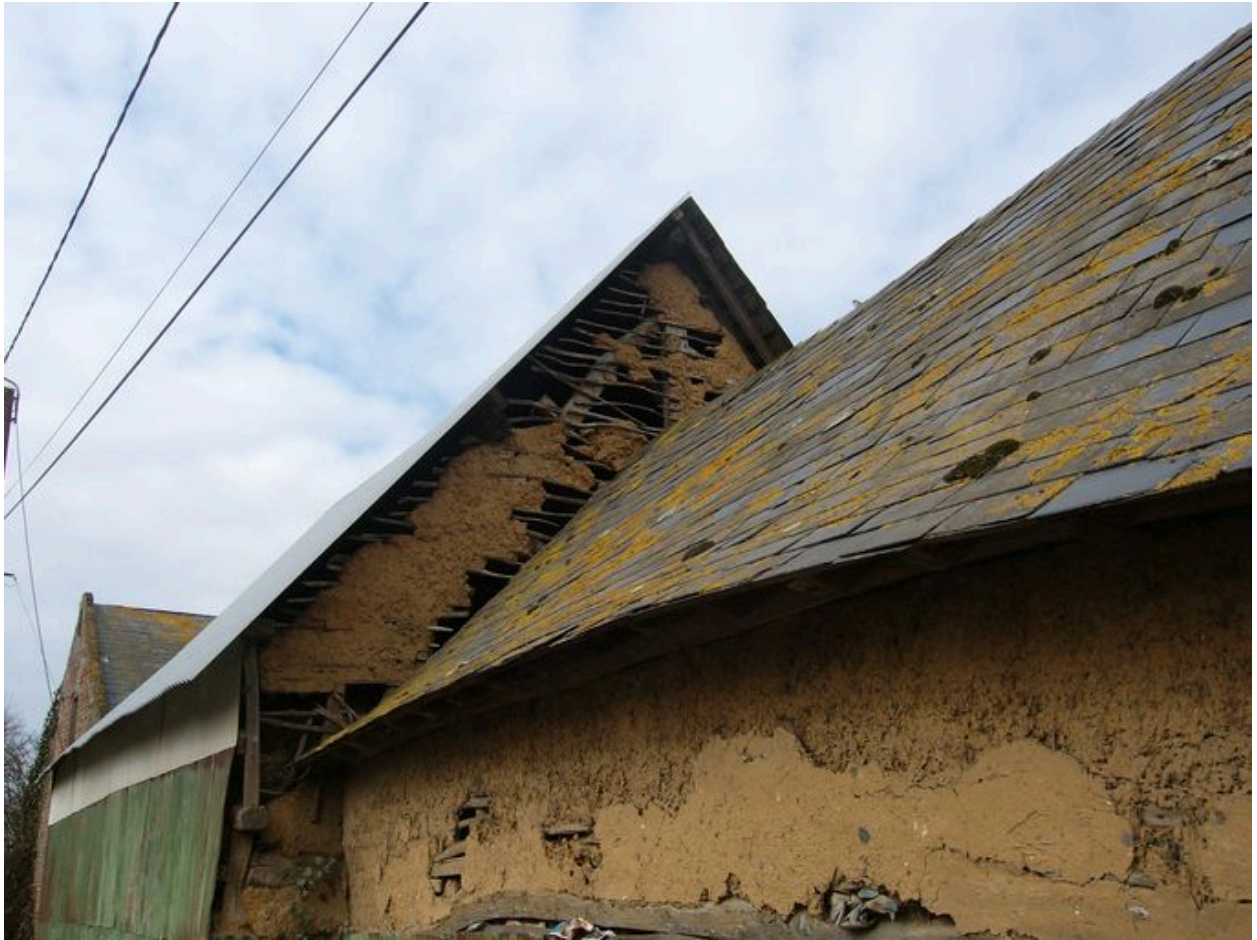
Vue du décrochement du pignon de l'écurie.
