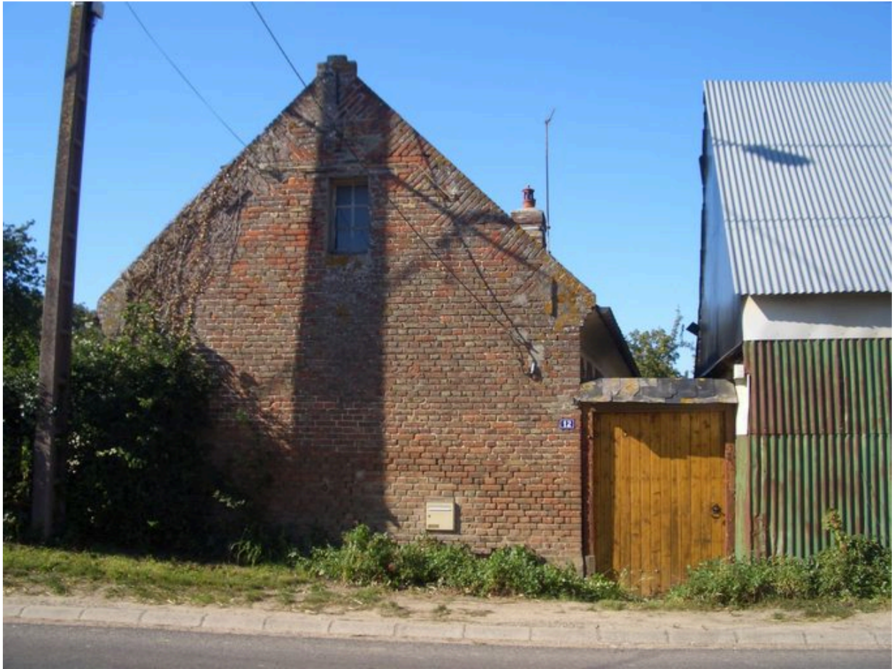
Vue du pignon nord en brique.
