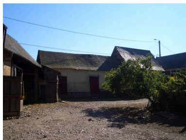
Vue des étables et écuries au nord de la cour. Phot. Inès Guérin IVR22_20068005274NUCA
