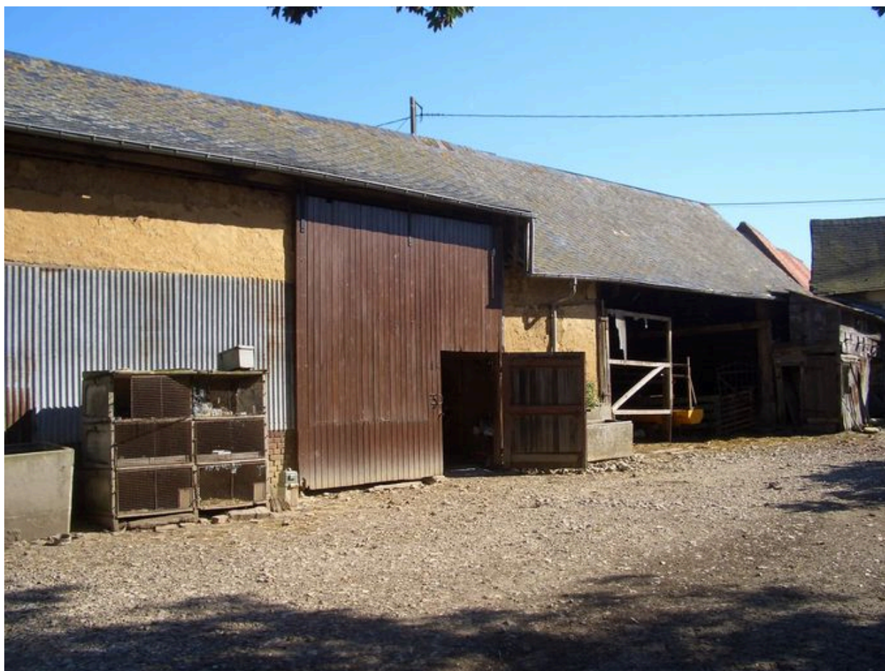
Vue de la partie nord de la grange.
