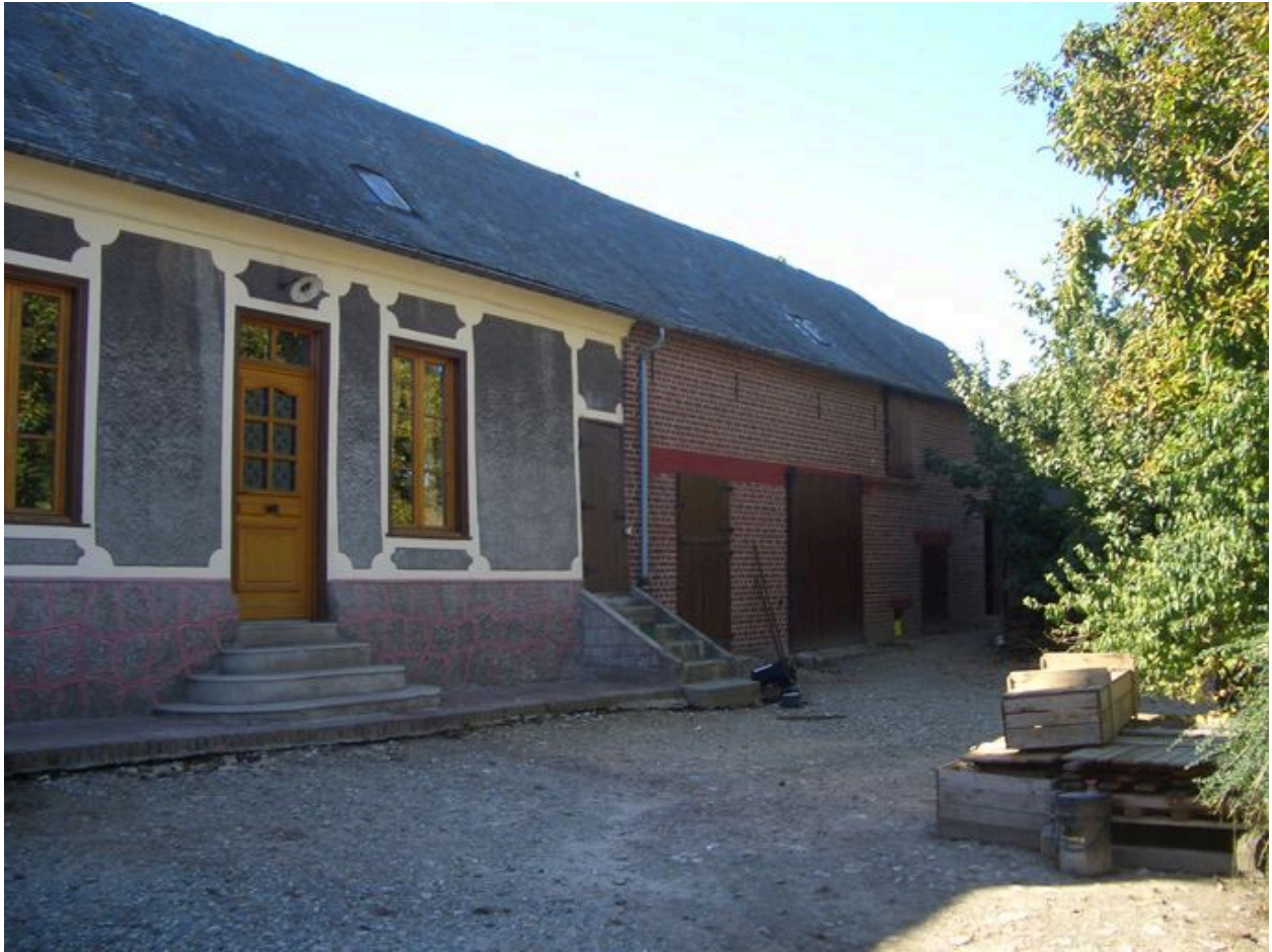
Vue des écuries placées dans le prolongement de la partie habitable.
