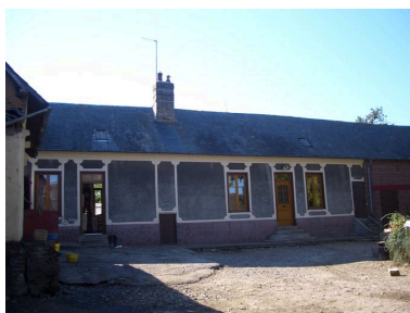
Façade principale du logis. Phot. Inès Guérin IVR22_20068005263NUCA
