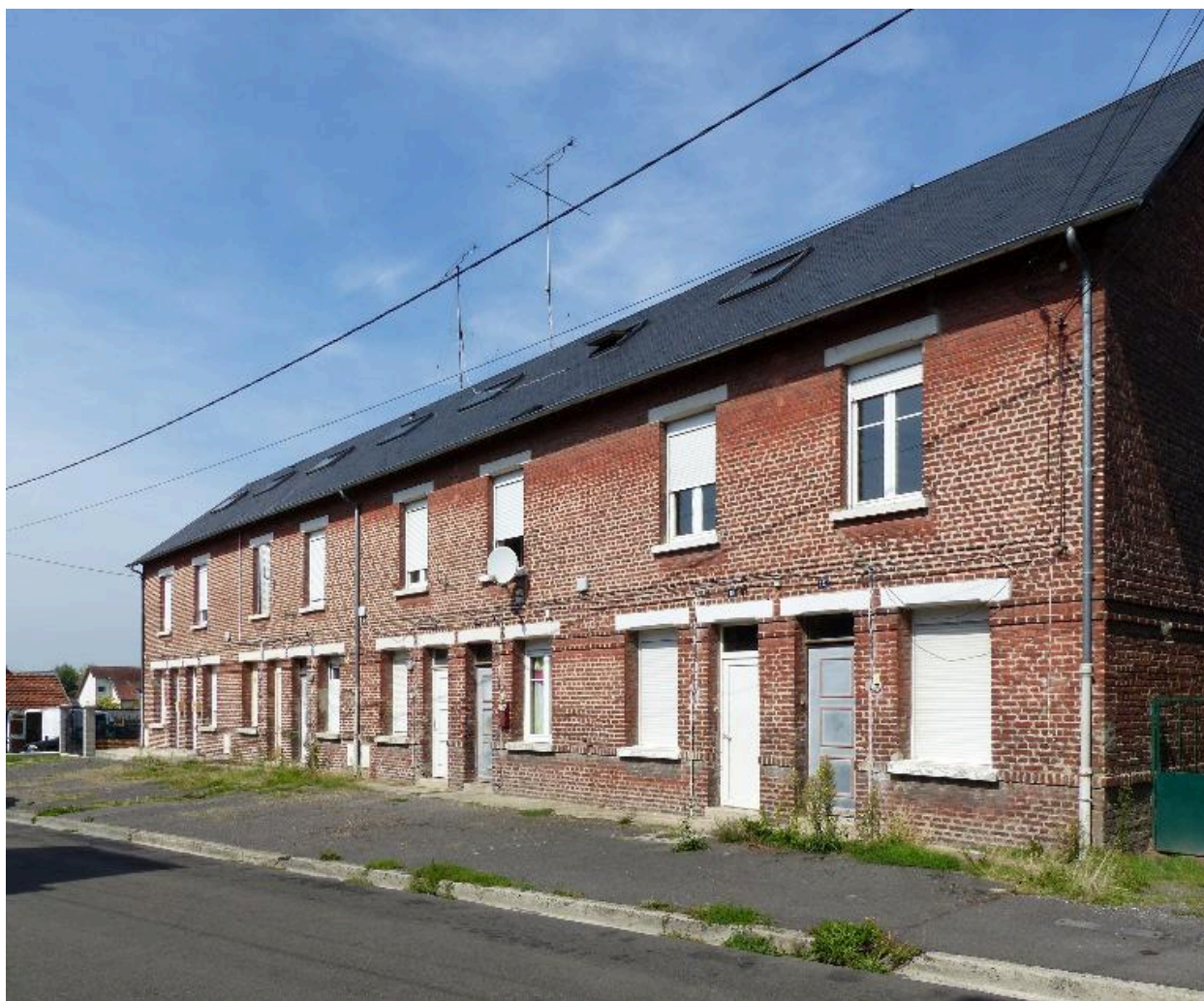
Logement d'ouvriers, rue Jules-Ferry.
