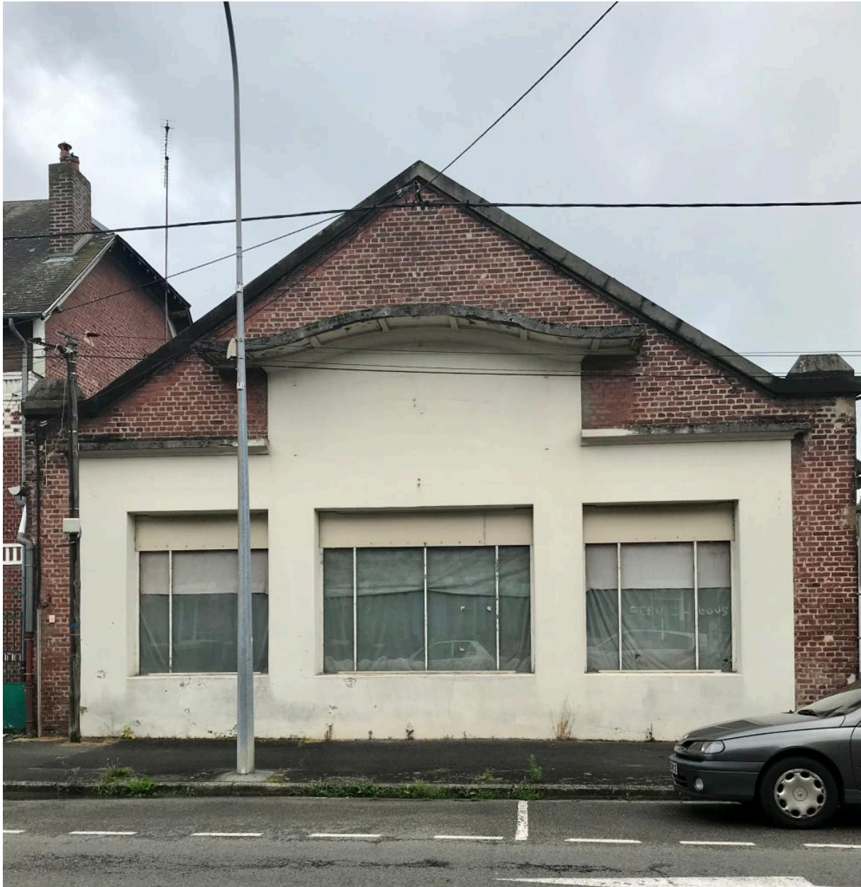
Ancien atelier de construction mécanique Oudin-L'Héronnelle, avenue Jean-Jaurès.
