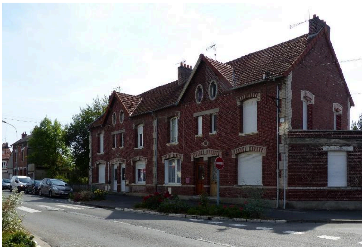
Maison à quatre unités d'habitation, 47 à 53 avenue Jean-Jaurès.
