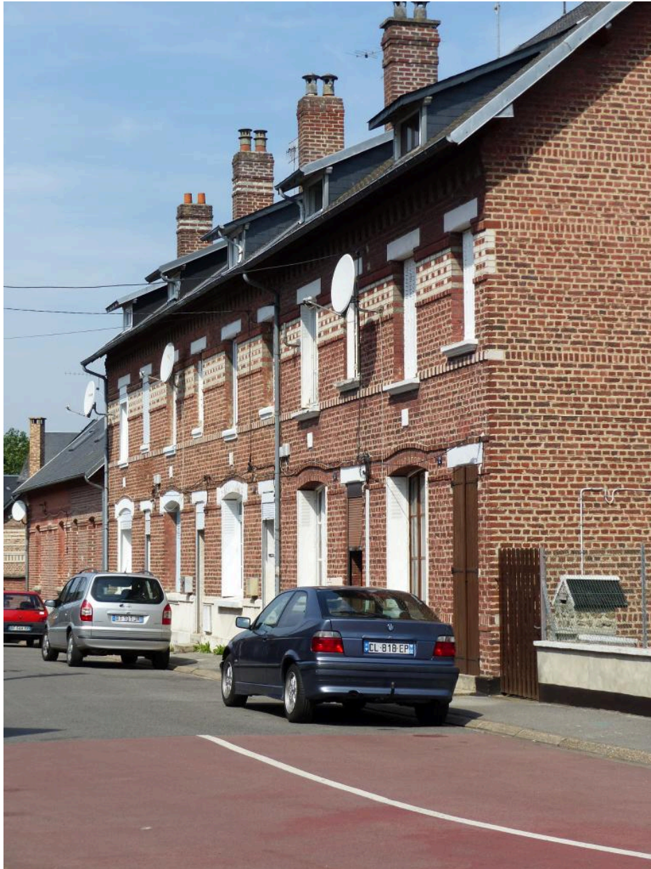
Logements, rue Laurent-Delionne.
