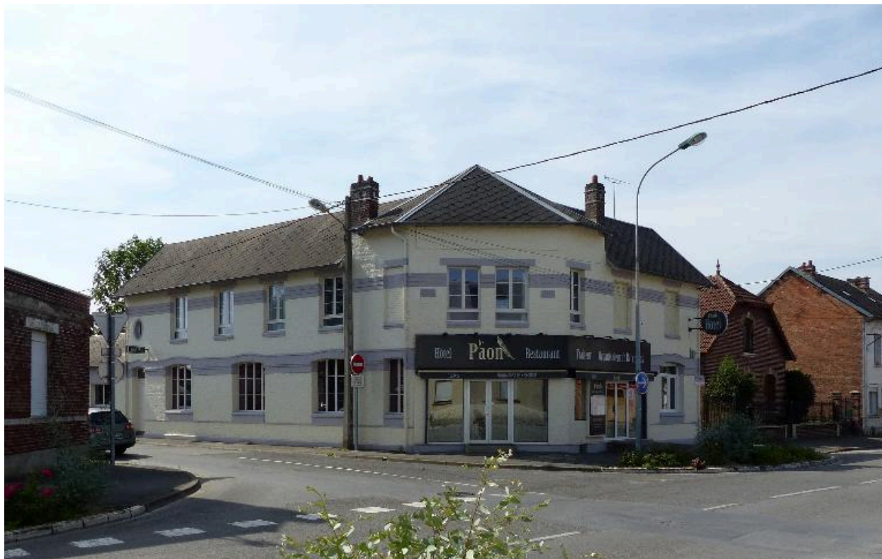
Hôtel du Paon (anciennement Central-Hôtel), avenue Jean-Jaurès.
