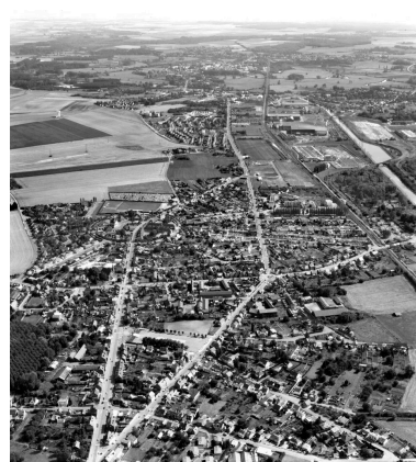
Vue aérienne vers l'est, en 1992. Phot. Phot'R IVR22_19920202614P
