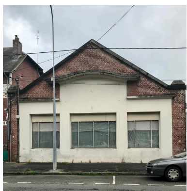
Ancien café, rue Raymond-Poincaré. Phot. Isabelle Barbedor IVR32_20170205289NUCA
