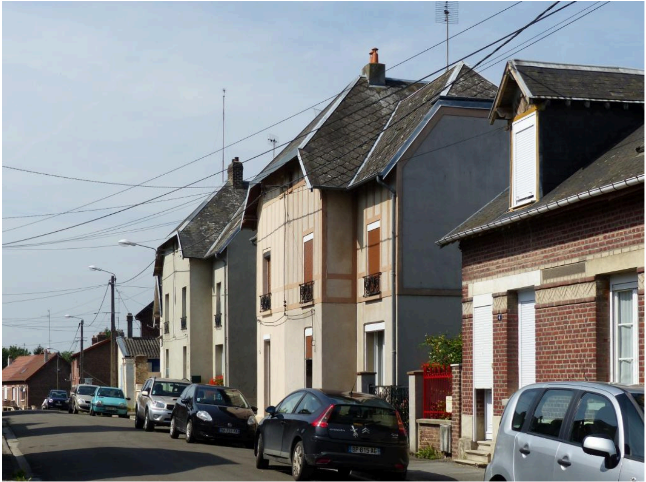
Maisons, rue Jules-Ferry.
