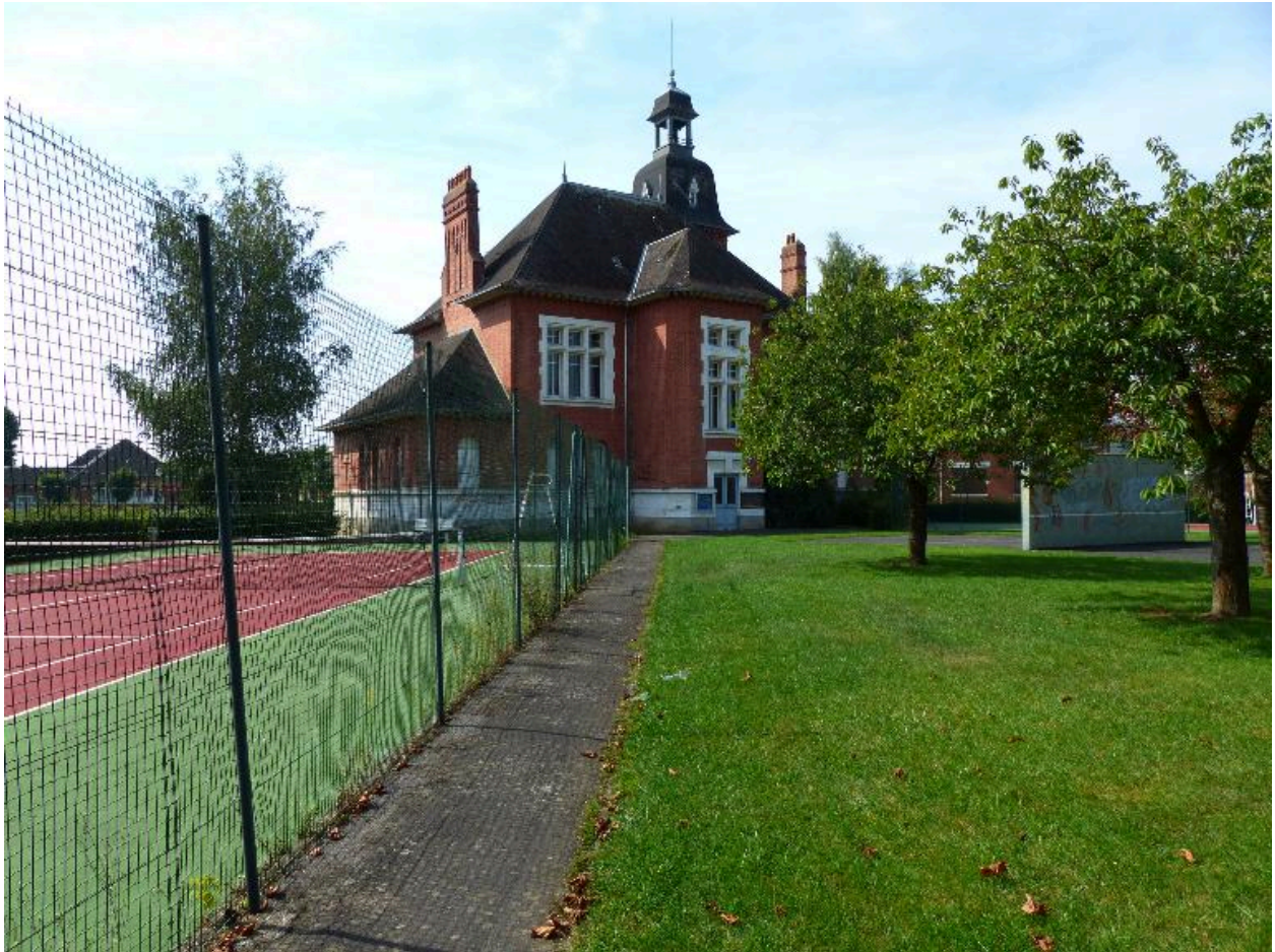
Vue de situation depuis le nord.
