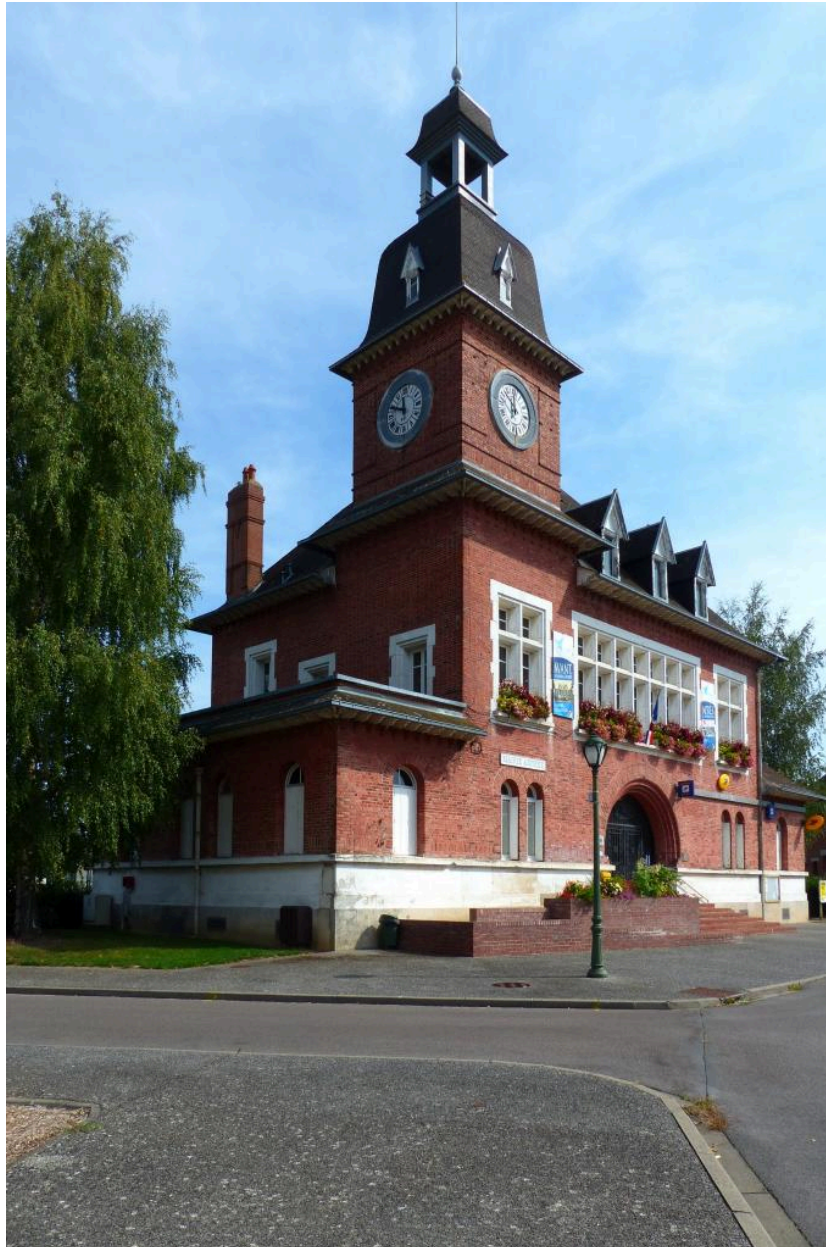
Vue générale, depuis le sud-ouest.
