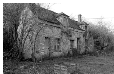
Dépendances : élévation nord. Phot. Benoît Dufournier IVR22_19936000015Z
