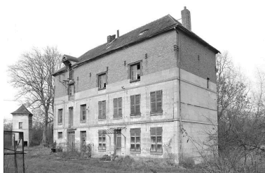
Façade antérieure du moulin. Phot. Benoît Dufournier IVR22_19936000026Z
