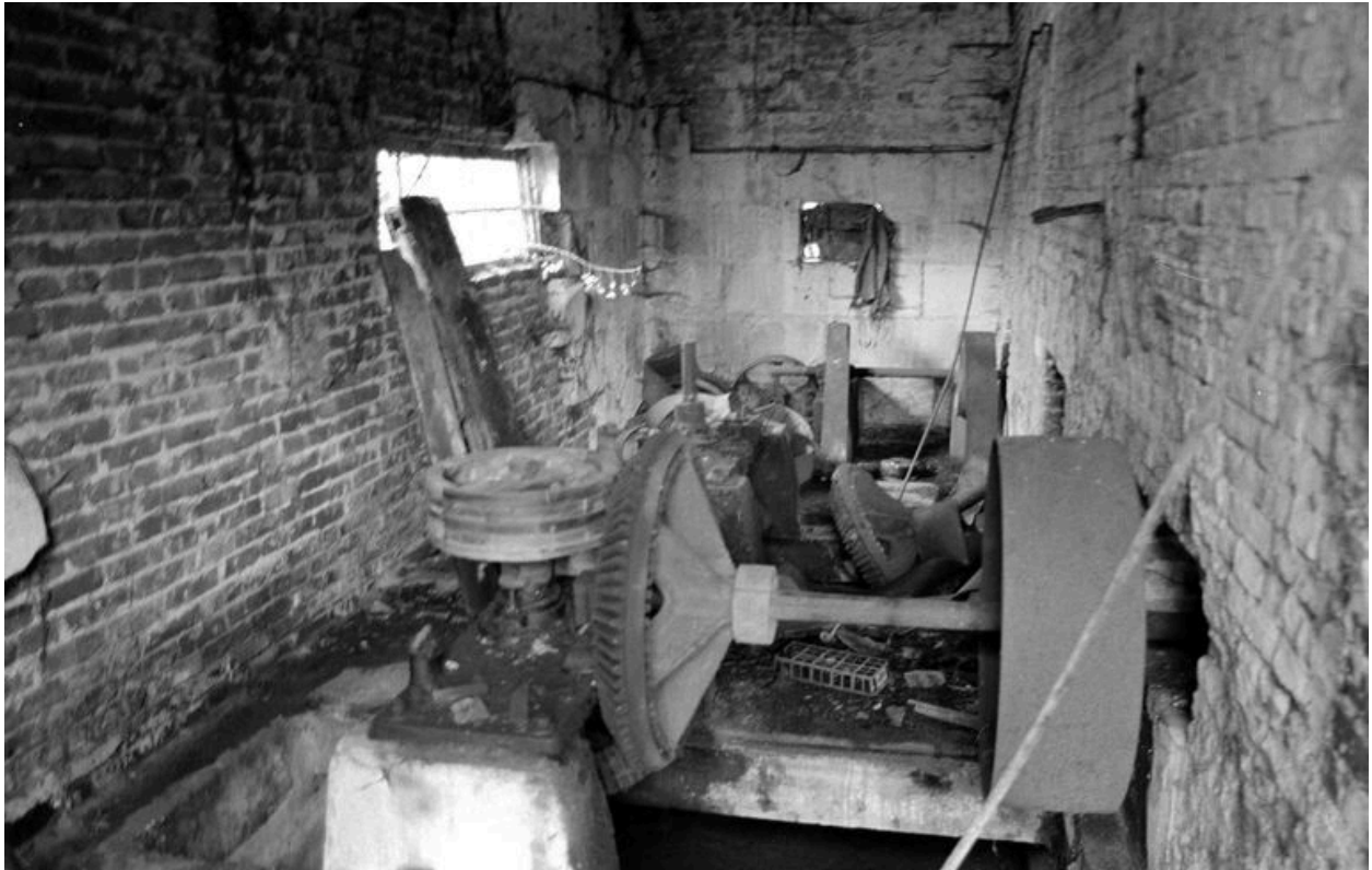
Intérieur de la cage du moulin abritant le mécanisme de transmission.
