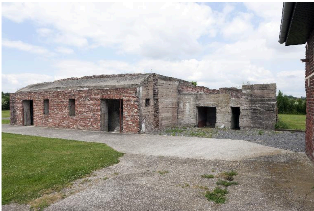
Vue générale vers l'ouest. A droite, le poste d'observation
