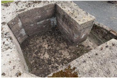
Vue en plongée sur le poste d'observation Phot. Jean-Marc Ramette IVR31_20145904494NUCA
