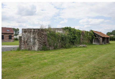
Revers de la casemate, vers le sud Phot. Jean-Marc Ramette IVR31_20145906018NUCA
