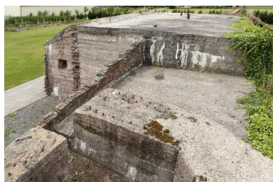
Couvrement depuis le poste d'observation Phot. Jean-Marc Ramette IVR31_20145906019NUCA
