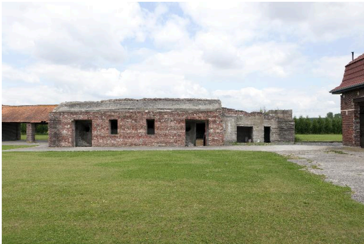
La casemate dans d'anciennes dépendances de la ferme, vers le nord-ouest
