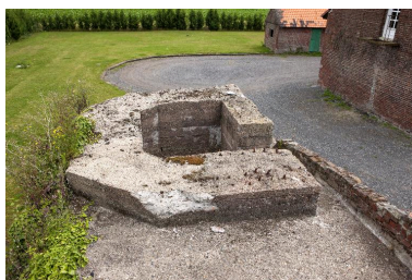
Poste d'observation depuis le couvrement de la casemate, vers le sud-ouest Phot. Jean-Marc Ramette IVR31_20145904493NUCA
