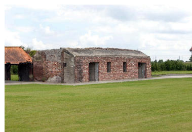
La casemate dans d'anciennes dépendances de la ferme, vers le nord Phot. Jean-Marc Ramette IVR31_20145906017NUCA
