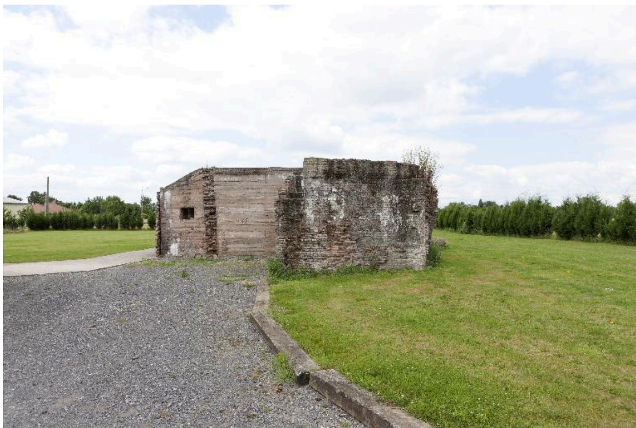
Pignon nord vers le sud-ouest
