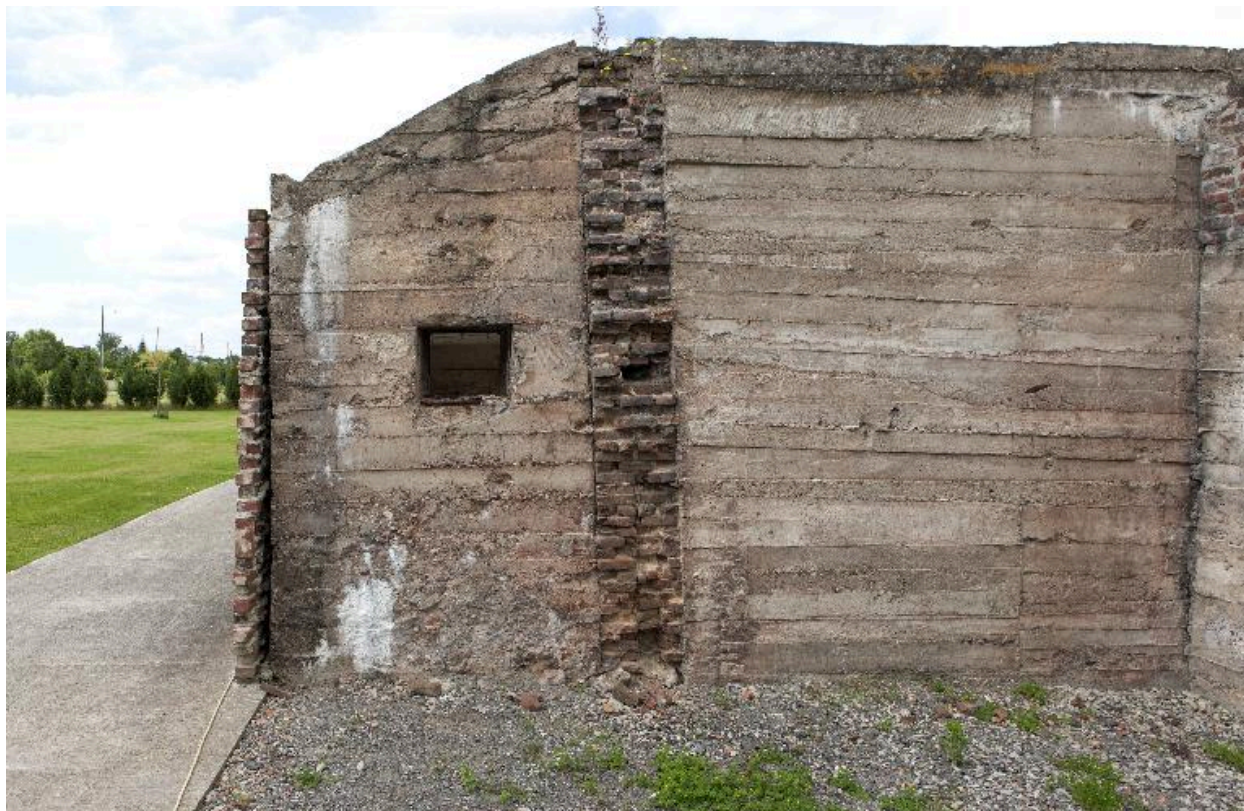
Pignon nord vers le sud-ouest. Détail
