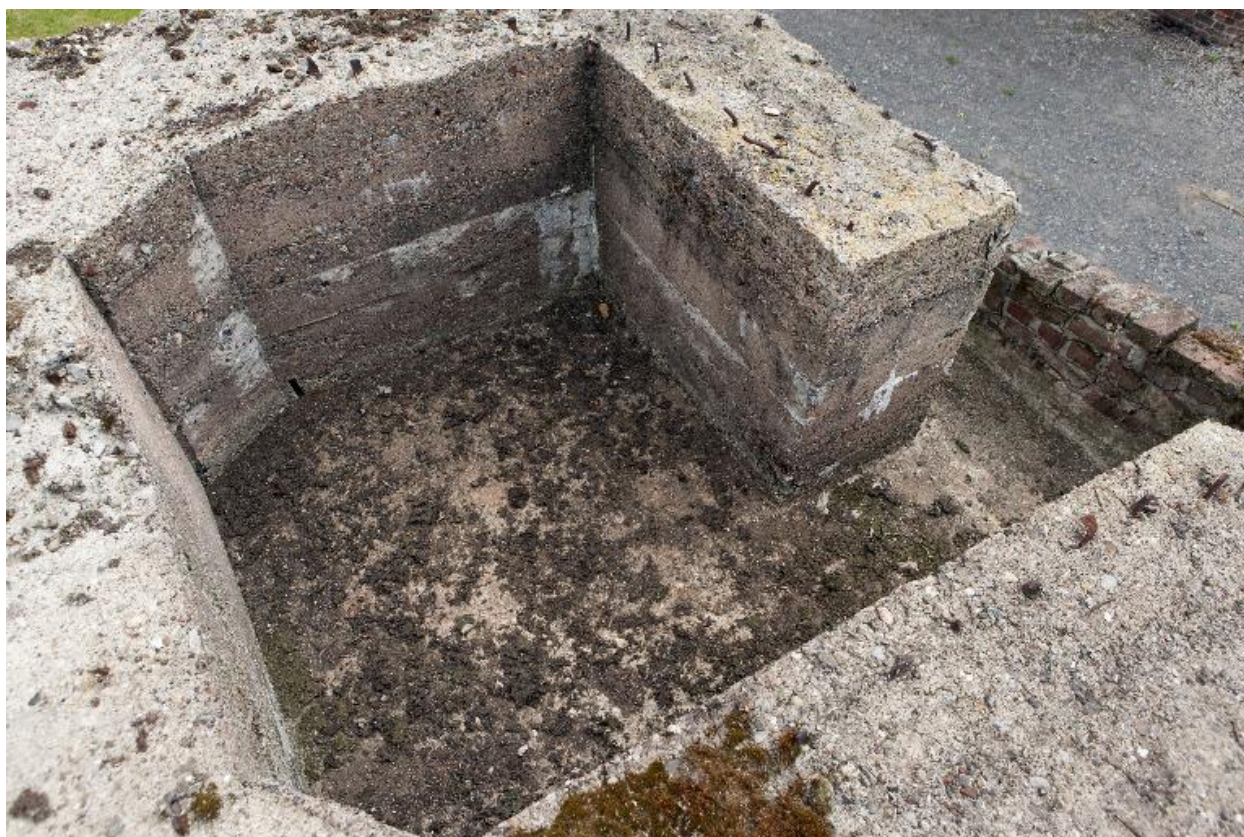
Vue en plongée sur le poste d'observation
