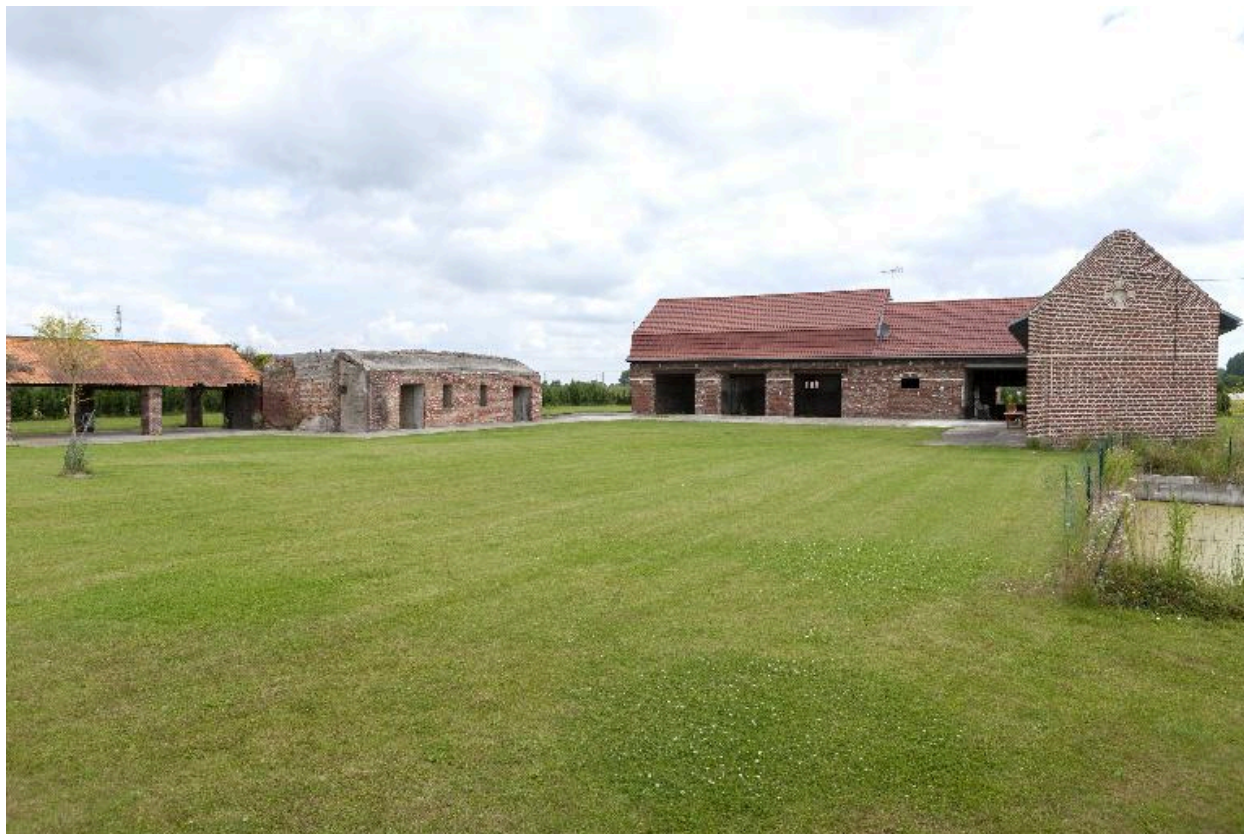
Vue générale de l'ancienne ferme et ses dépendances, vers le nord-est
