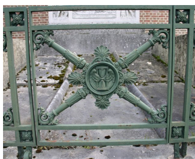
Vantail de la grille en fonte. Phot. Caroline Vincent IVR22_20068000666NUCA
